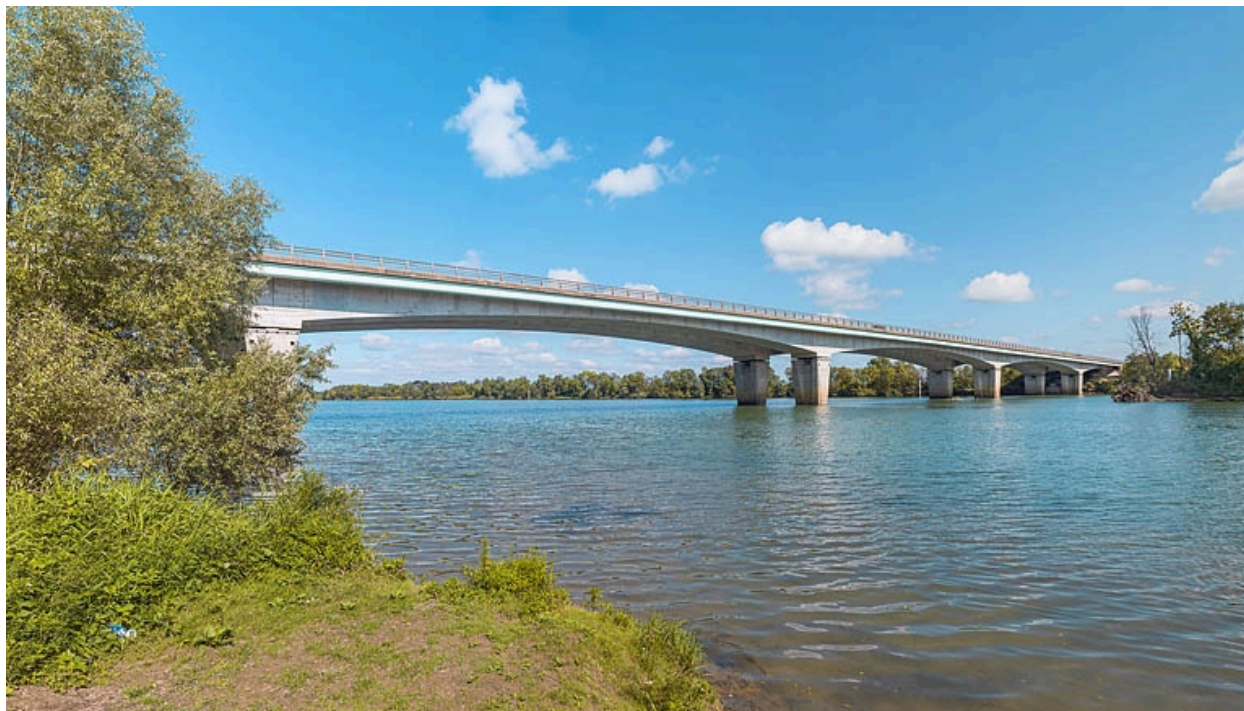
Vue d'ensemble du pont depuis la rive droite.
