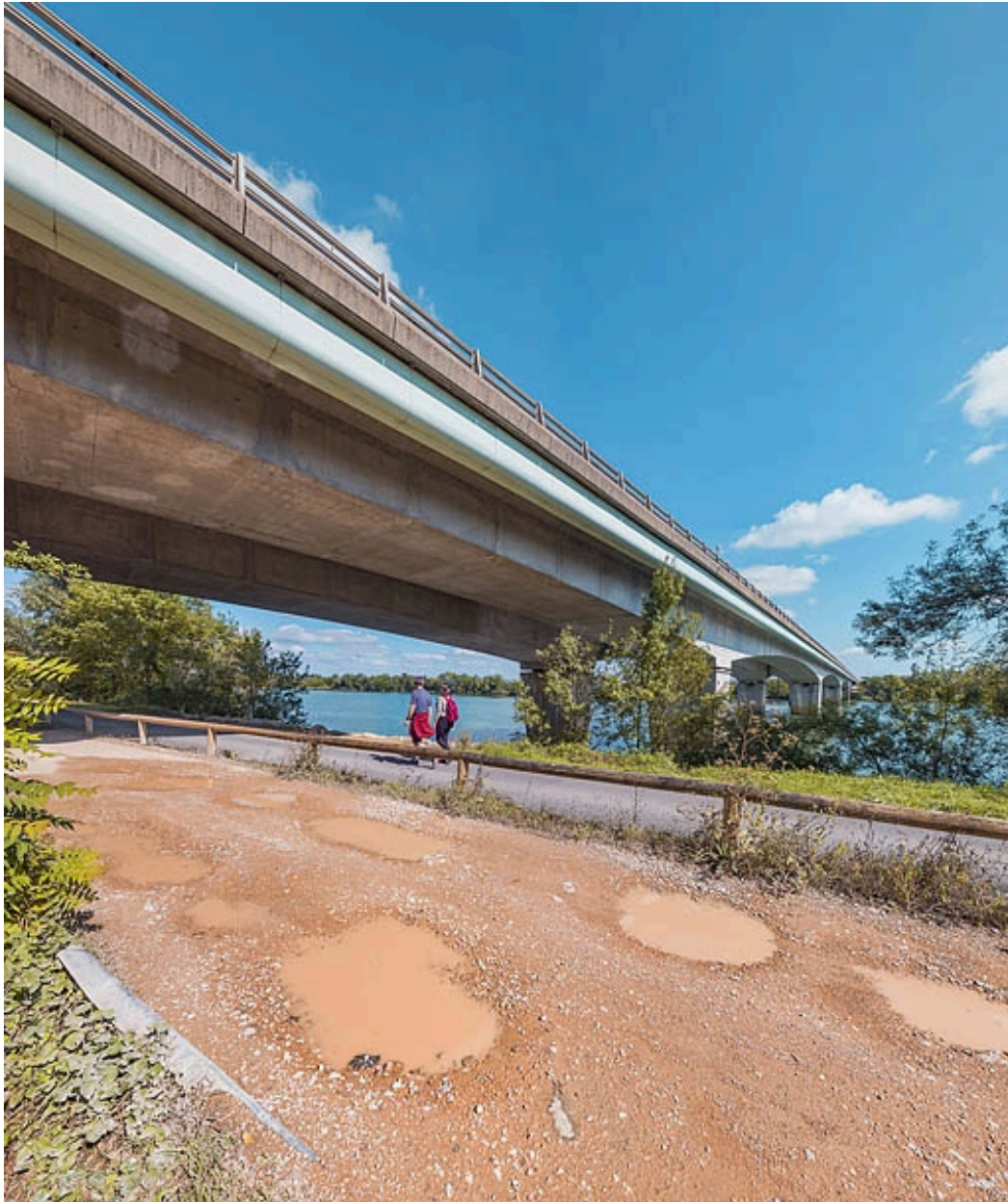
Le pont depuis la véloroute, rive droite.
