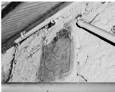
Blason remployé sur le bâtiment de 1860, côté ancienne cour. Phot. Jérôme Mongreville IVR43_19872500438X
