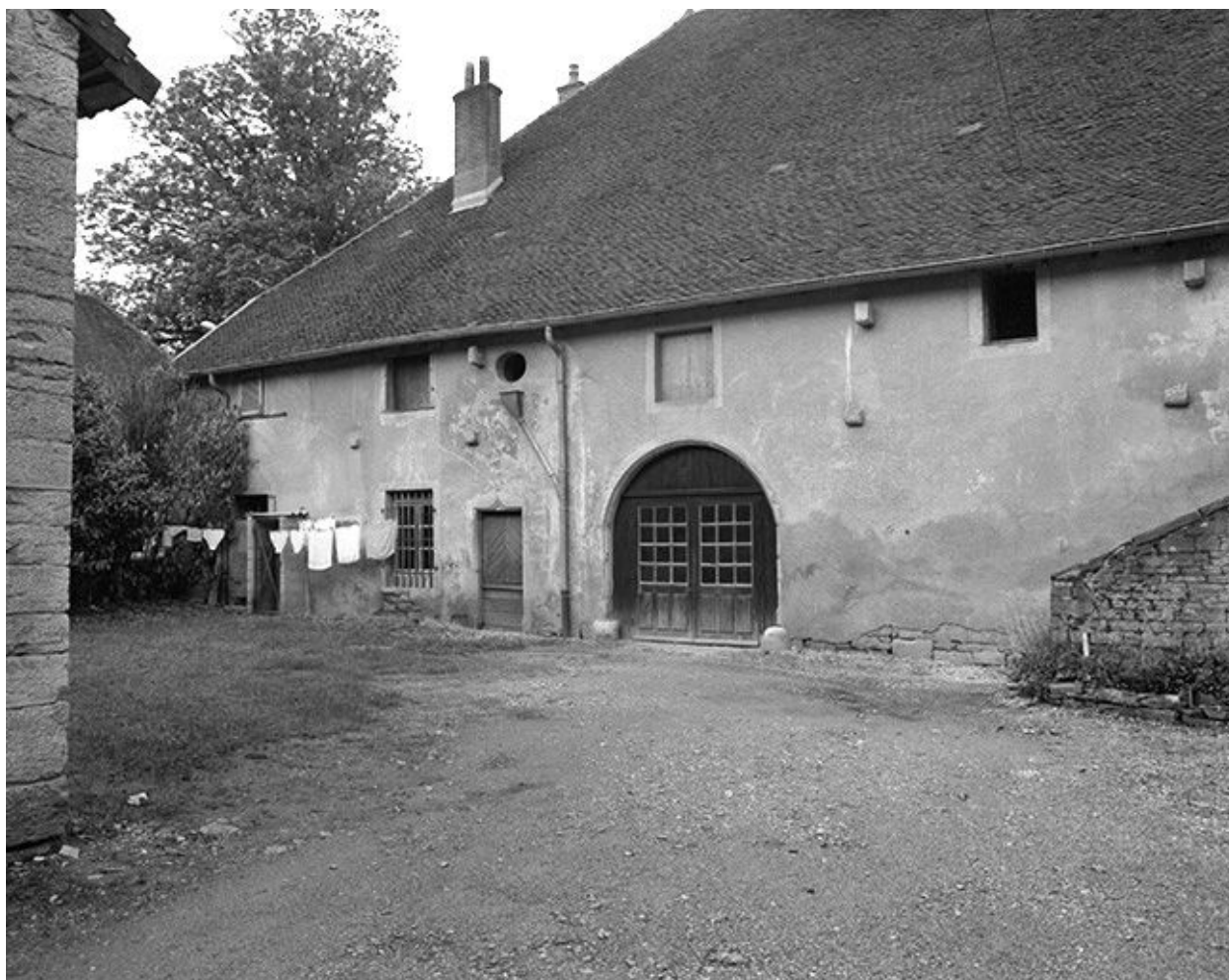
Façade antérieure, partie gauche.
