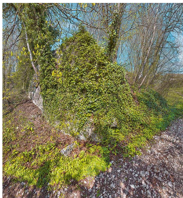
Tronçon de rempart ruiné. Phot. Thierry Kuntz IVR43_20252500461NUC4A
