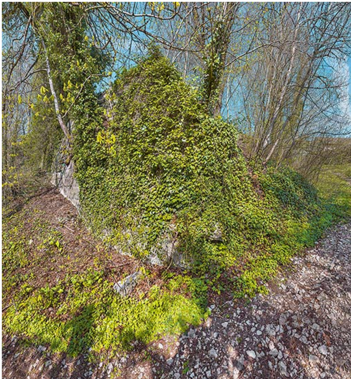
Tronçon de rempart ruiné.
