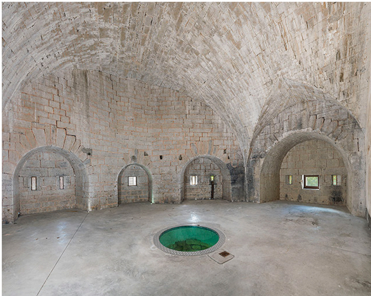
Le bastion du puits, vue générale intérieure. Le puits est au centre.
