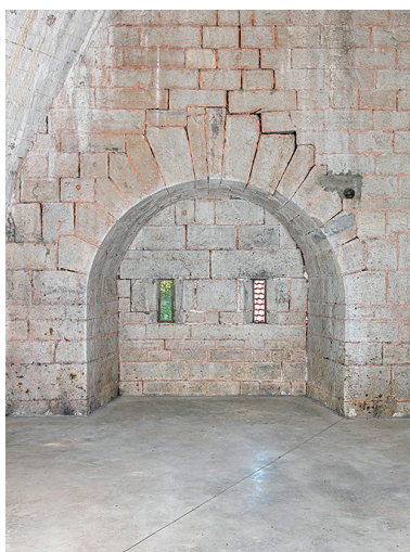
Bastion du puits : "alcove" avec embrasures de la face nord. Phot. Thierry Kuntz IVR43_20252500475NUC4A
