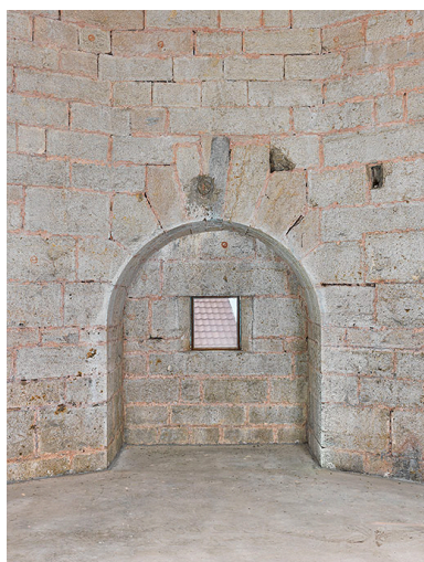
Bastion du puits : "alcove" avec embrasure du flanc nord. Phot. Thierry Kuntz IVR43_20252500474NUC4A
