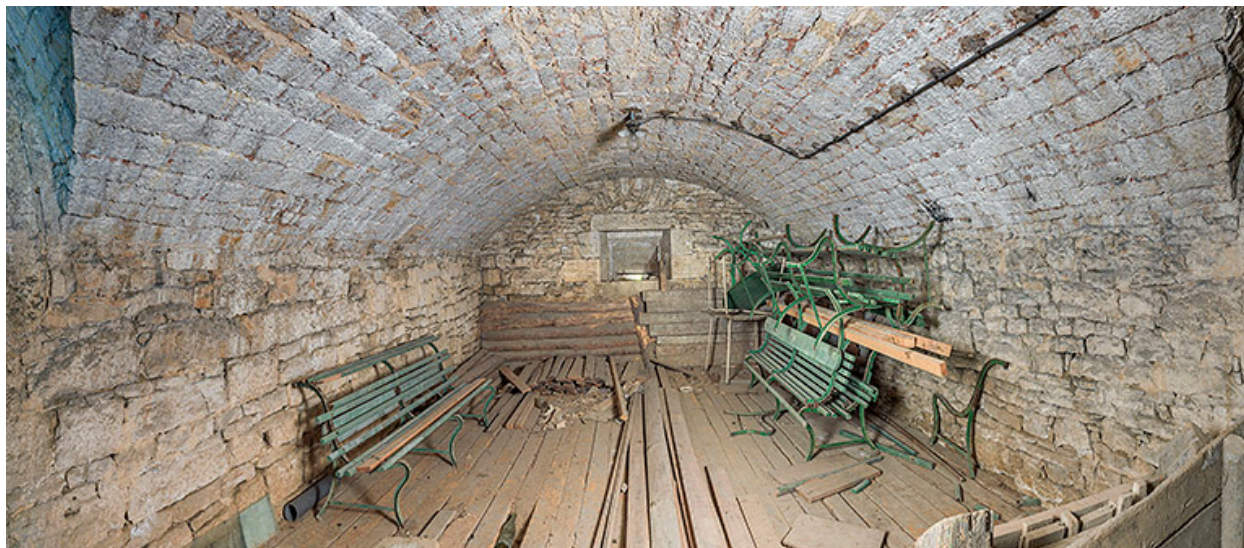
Vue générale d'une casemate.
