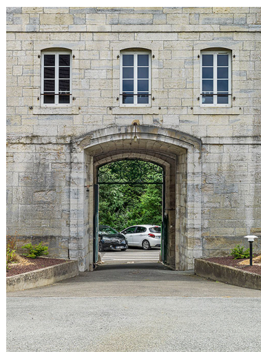
Le pavillon et son passage, vue depuis la cour intérieure.
