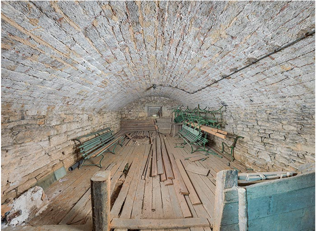
Casemate et sa voûte à l'épreuve.
