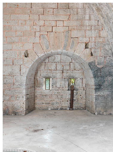
Bastion du puits : "alcove" avec embrasures de la face sud. Phot. Thierry Kuntz IVR43_20252500476NUC4A
