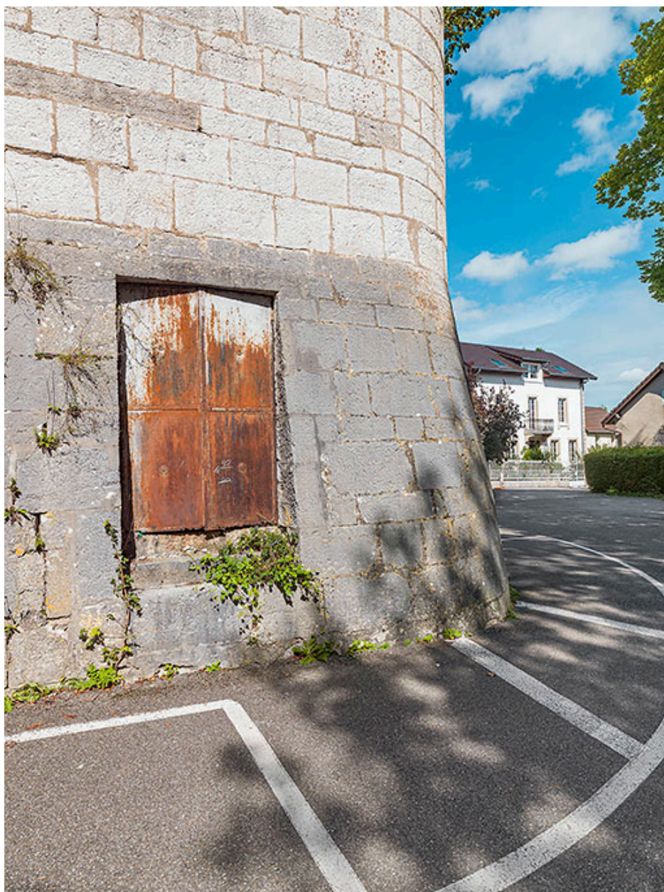
Poterne du demi-bastion.
