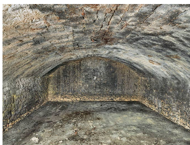
Autre casemate du niveau inférieur. Phot. Thierry Kuntz IVR43_20252500459NUC4A
