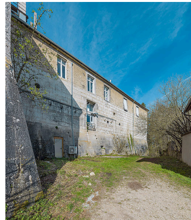
La partie nord du front bastionné (comprenant la poterne d'accès aux casemates). Phot. Thierry Kuntz IVR43_20252500453NUC4A
