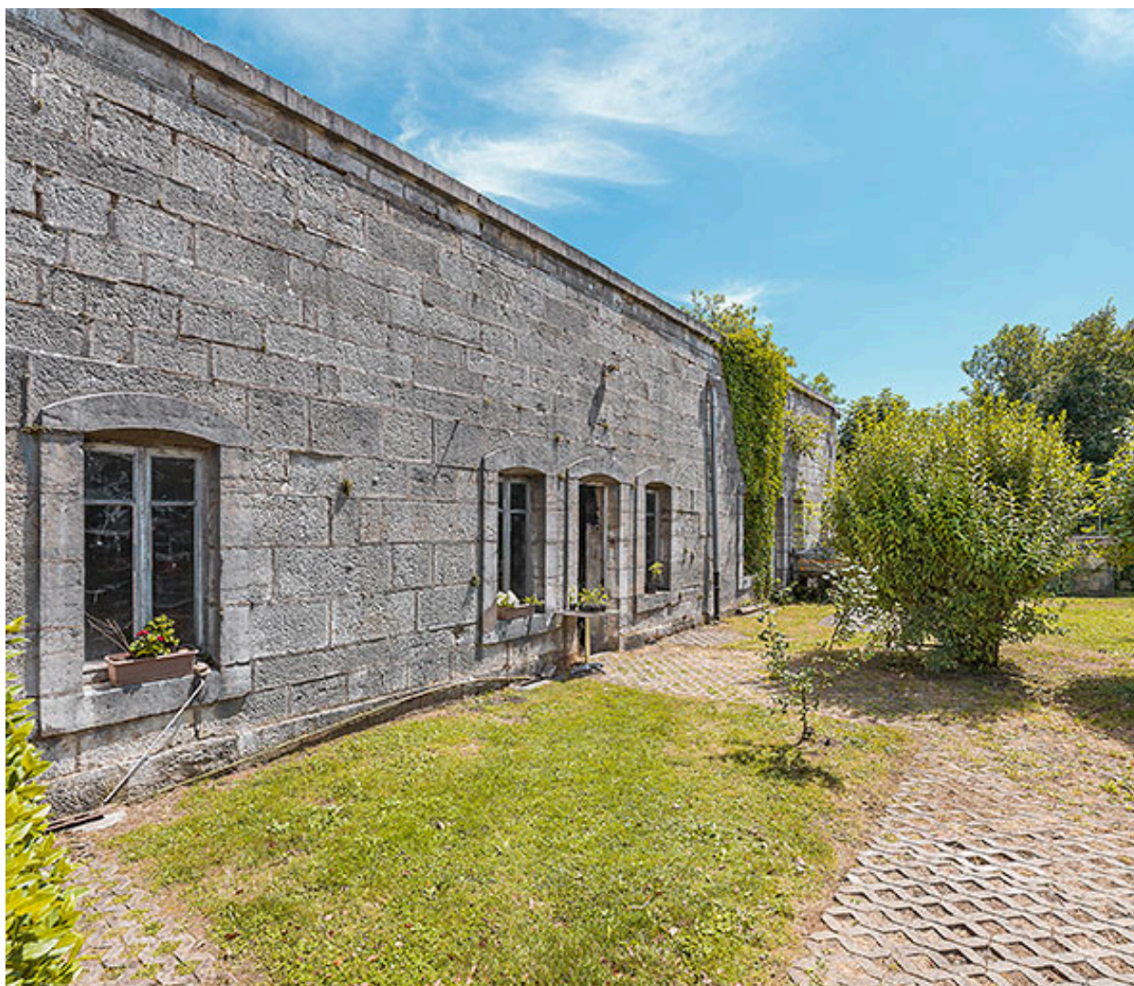
Les casemates conservées et transformées en locaux techniques.
