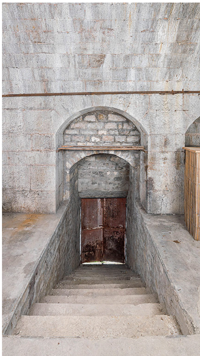
Escalier intérieur vers la poterne dans la casemate.
