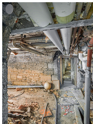
La galerie desservant les casemates du front bastionné, niveau inférieur. Phot. Thierry Kuntz IVR43_20252500454NUC4A
