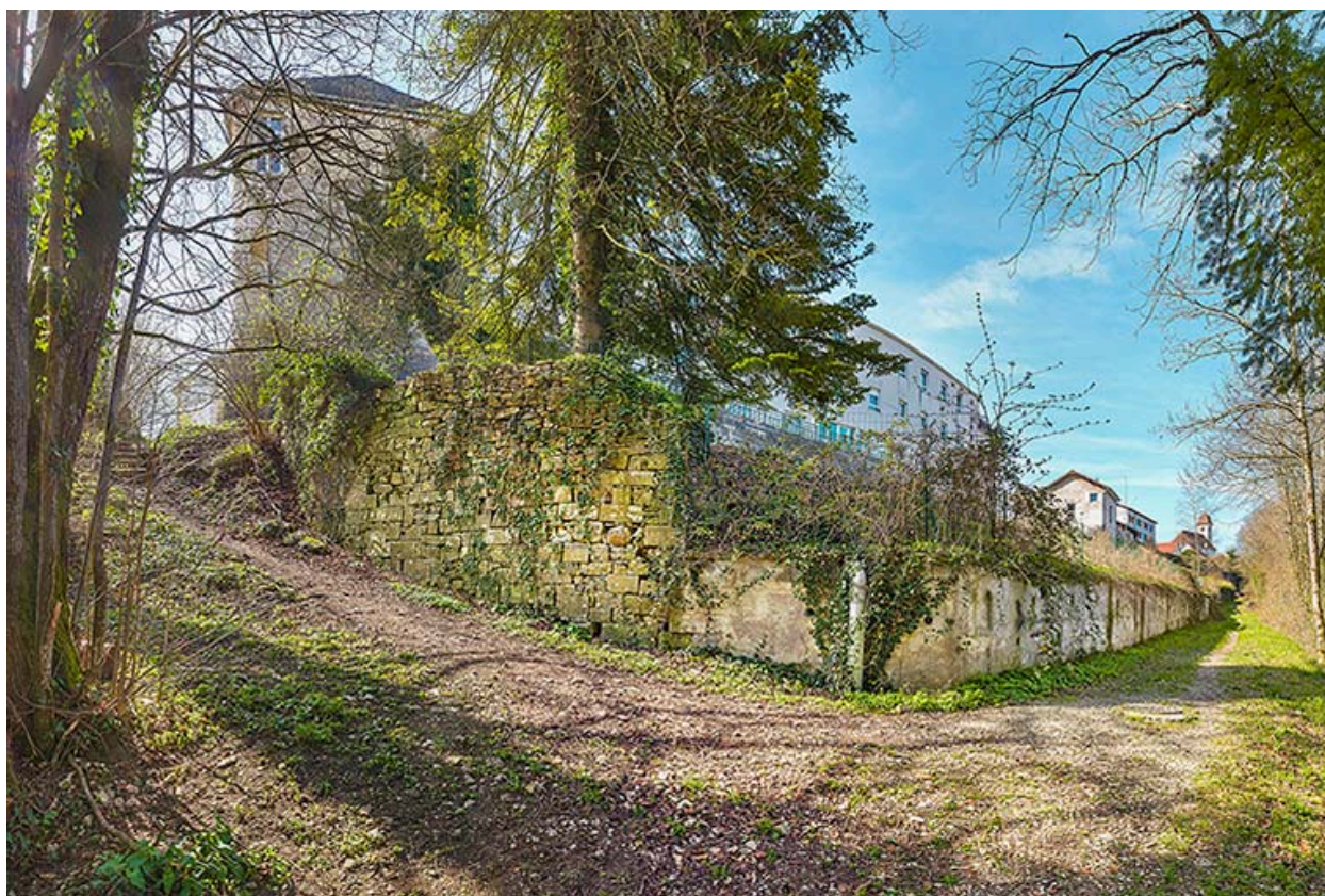
Mur d'enceinte dans le prolongement du front.
