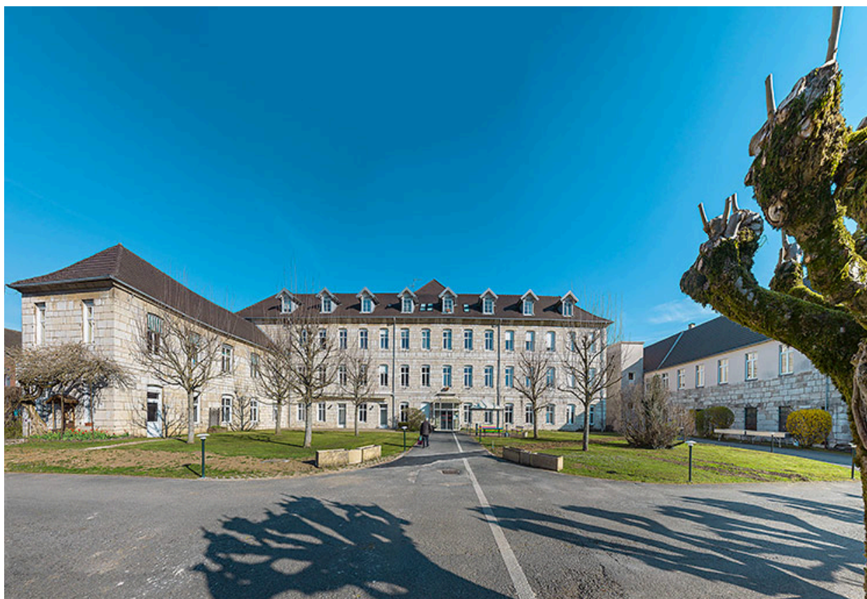
Vue générale du bâtiment construit au 19e siècle.
