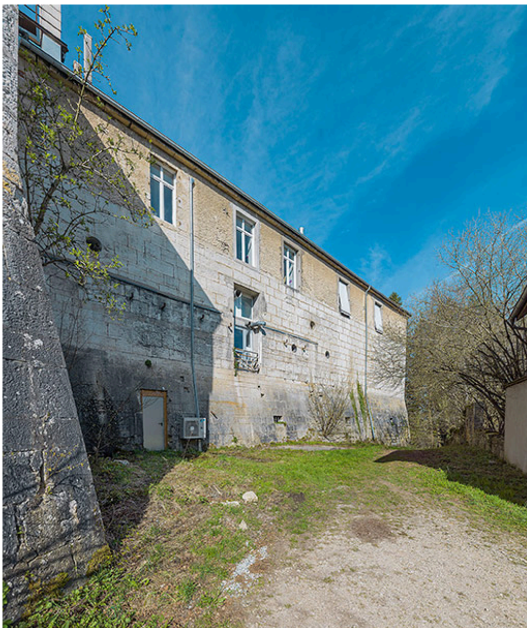
La partie nord du front bastionné (comprenant la poterne d'accès aux casemates).
