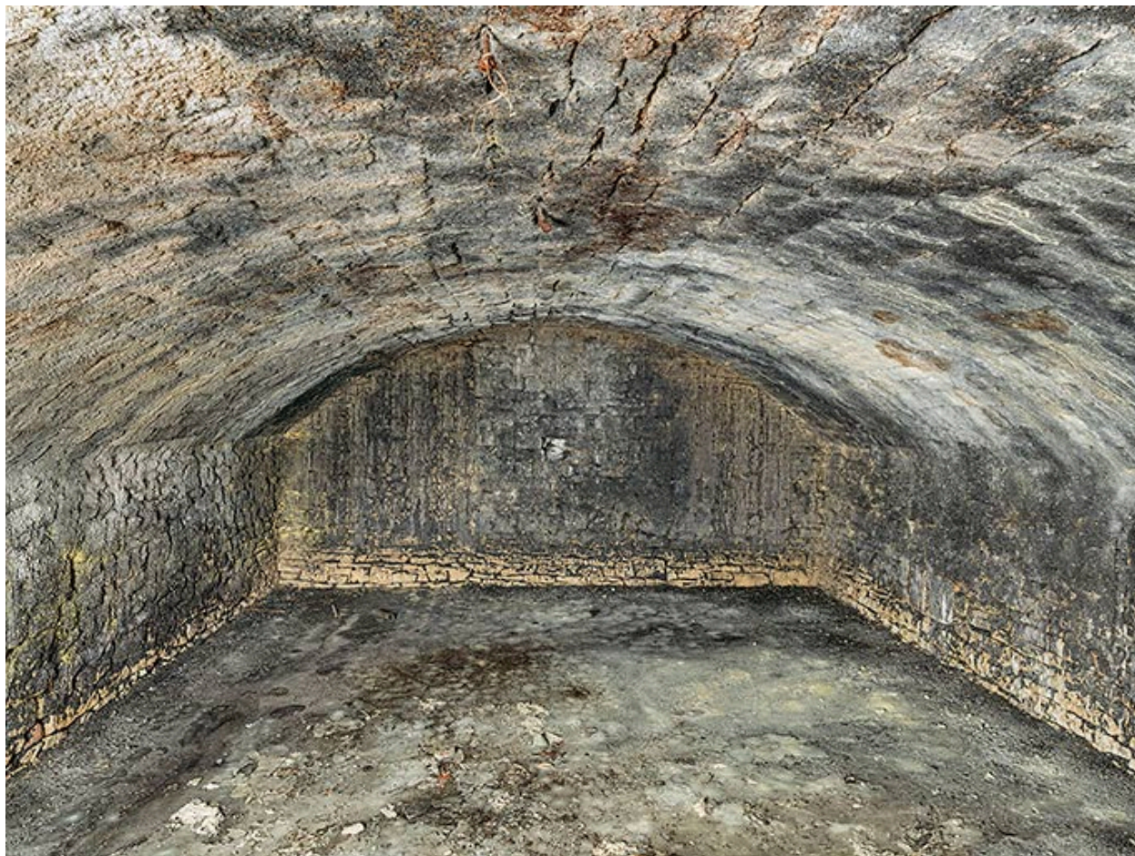
Autre casemate du niveau inférieur.
