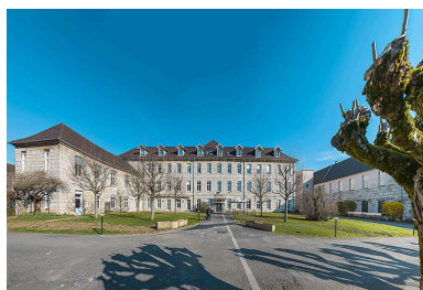
Vue générale du bâtiment construit au 19e siècle. Phot. Thierry Kuntz IVR43_20252500463NUC4A
