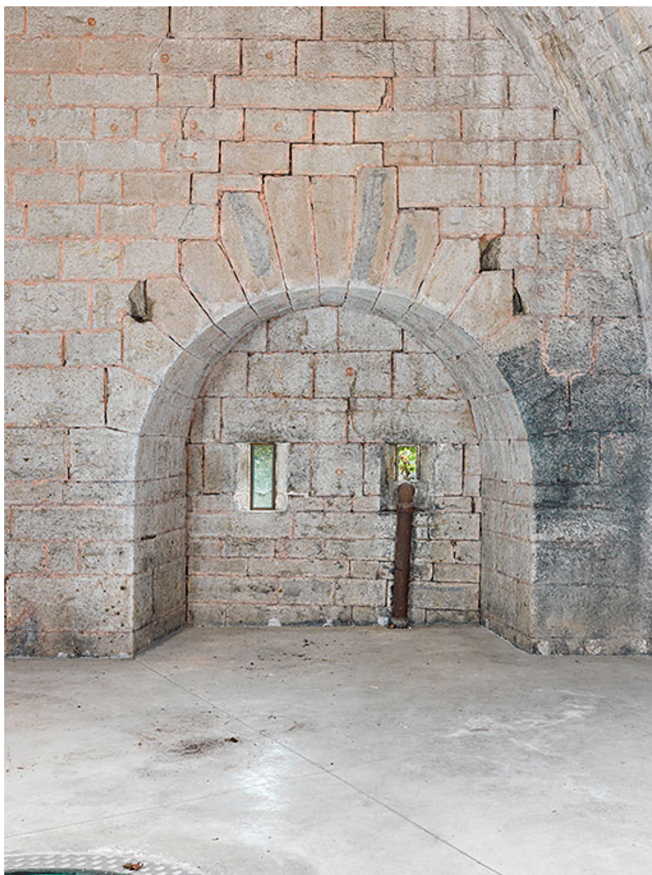
Bastion du puits : "alcove" avec embrasures de la face sud.
