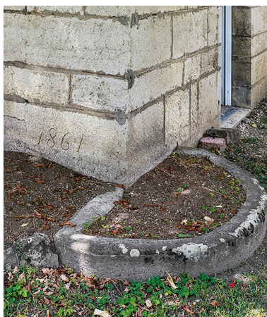
Date portée. Phot. Thierry Kuntz IVR43_20252500464NUC4A
