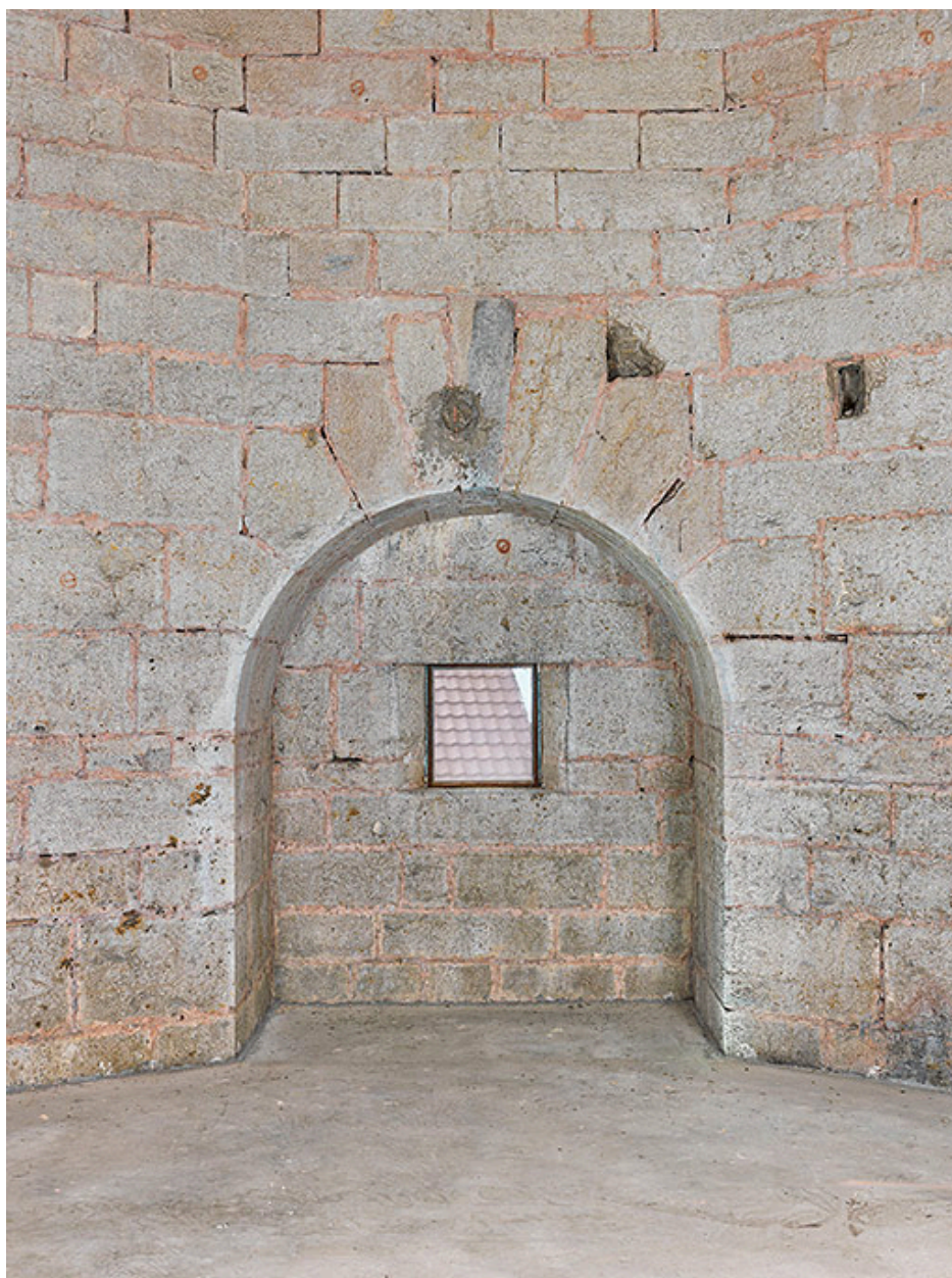
Bastion du puits : "alcove" avec embrasure du flanc nord.
