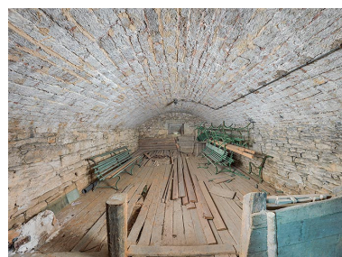
Casemate et sa voûte à l'épreuve. Phot. Thierry Kuntz IVR43_20252500457NUC4A
