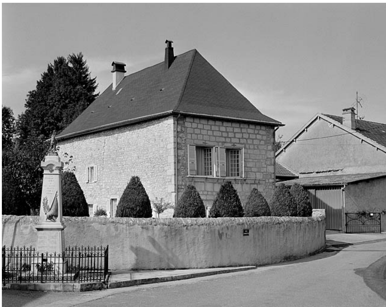
Demeure de notable dite le Château.
