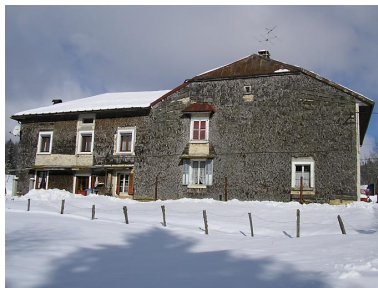
Façade postérieure. Phot. Marie-Pierre Reynet IVR43_20083900526NUC1A
