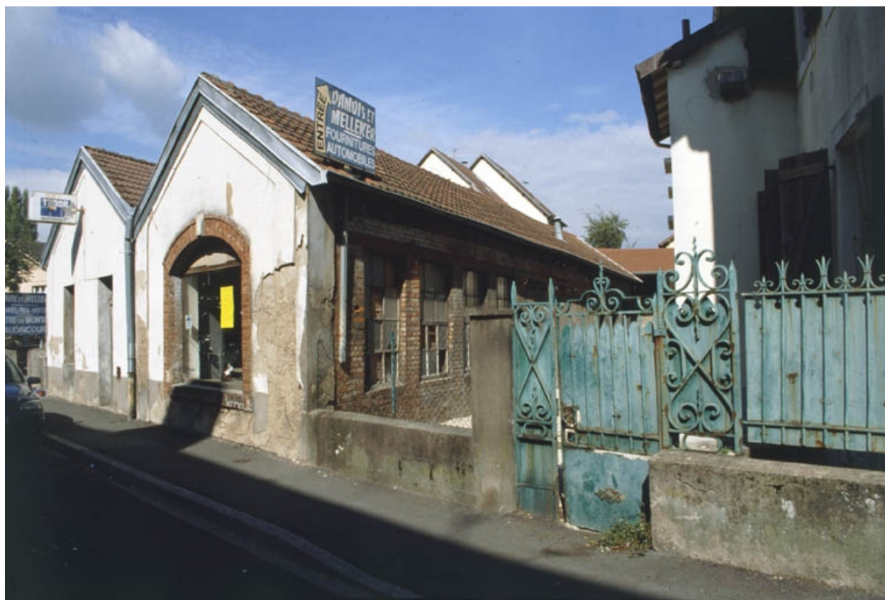
Vue depuis le sud.
