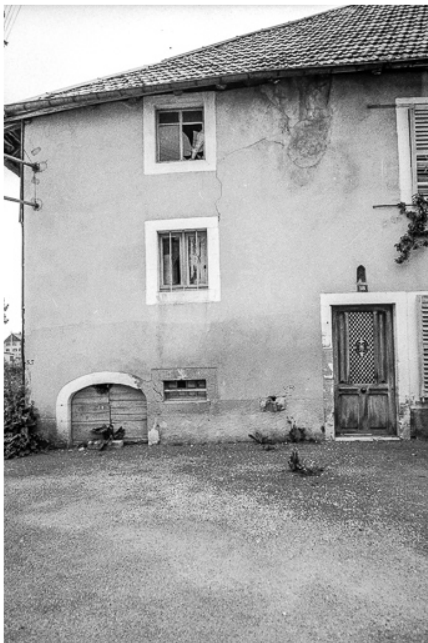
Ferme datée de 1797 : détail de la façade.
