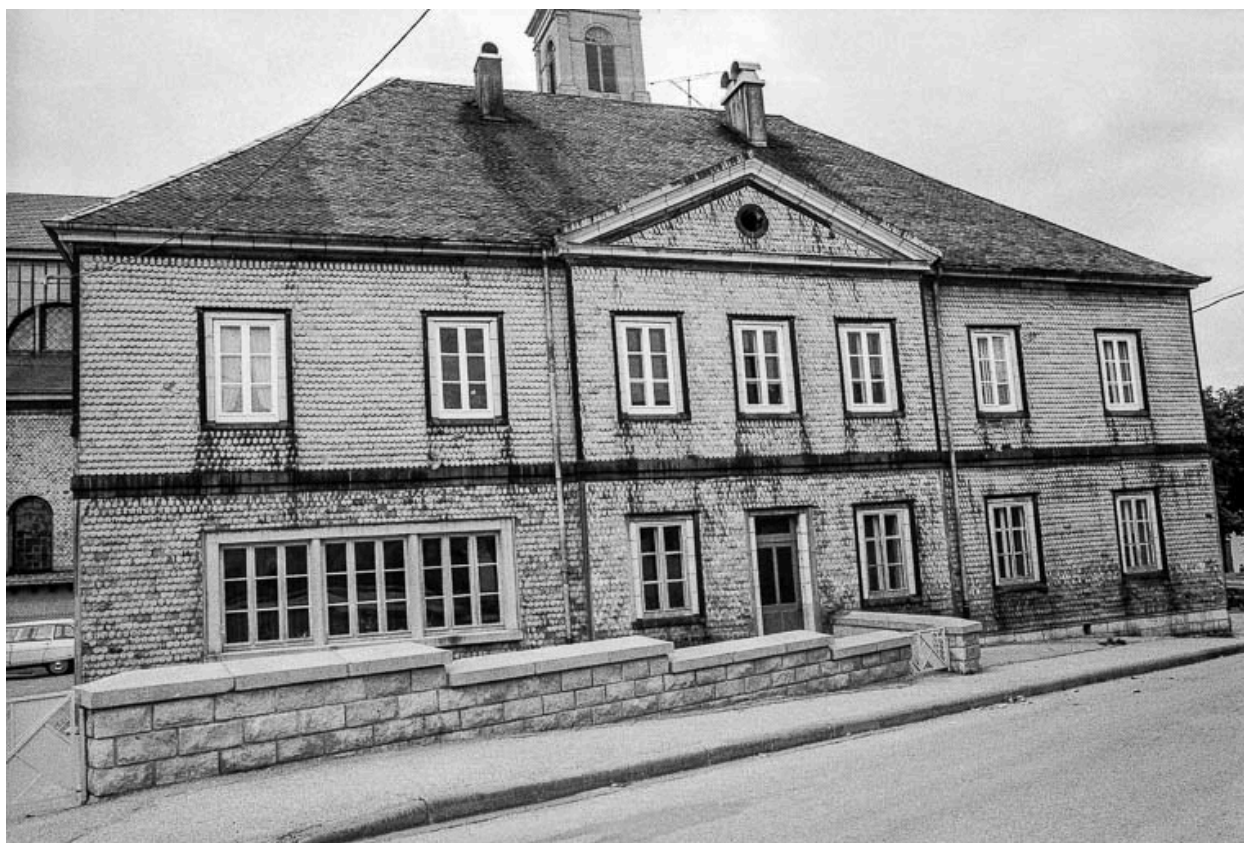
Ferme cadastrée 1975 F2 467, datée de 1854 : façade antérieure.
