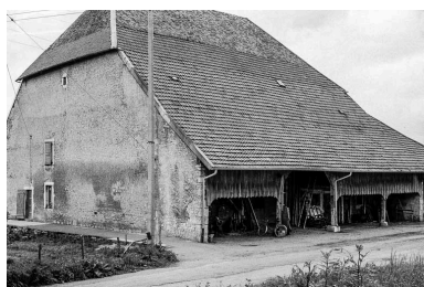
Ferme située rue du Moulin : vue du mur long-pan sur rue et façade latérale droite. Phot. Gilbert Poinot IVR43_19752500733Z
