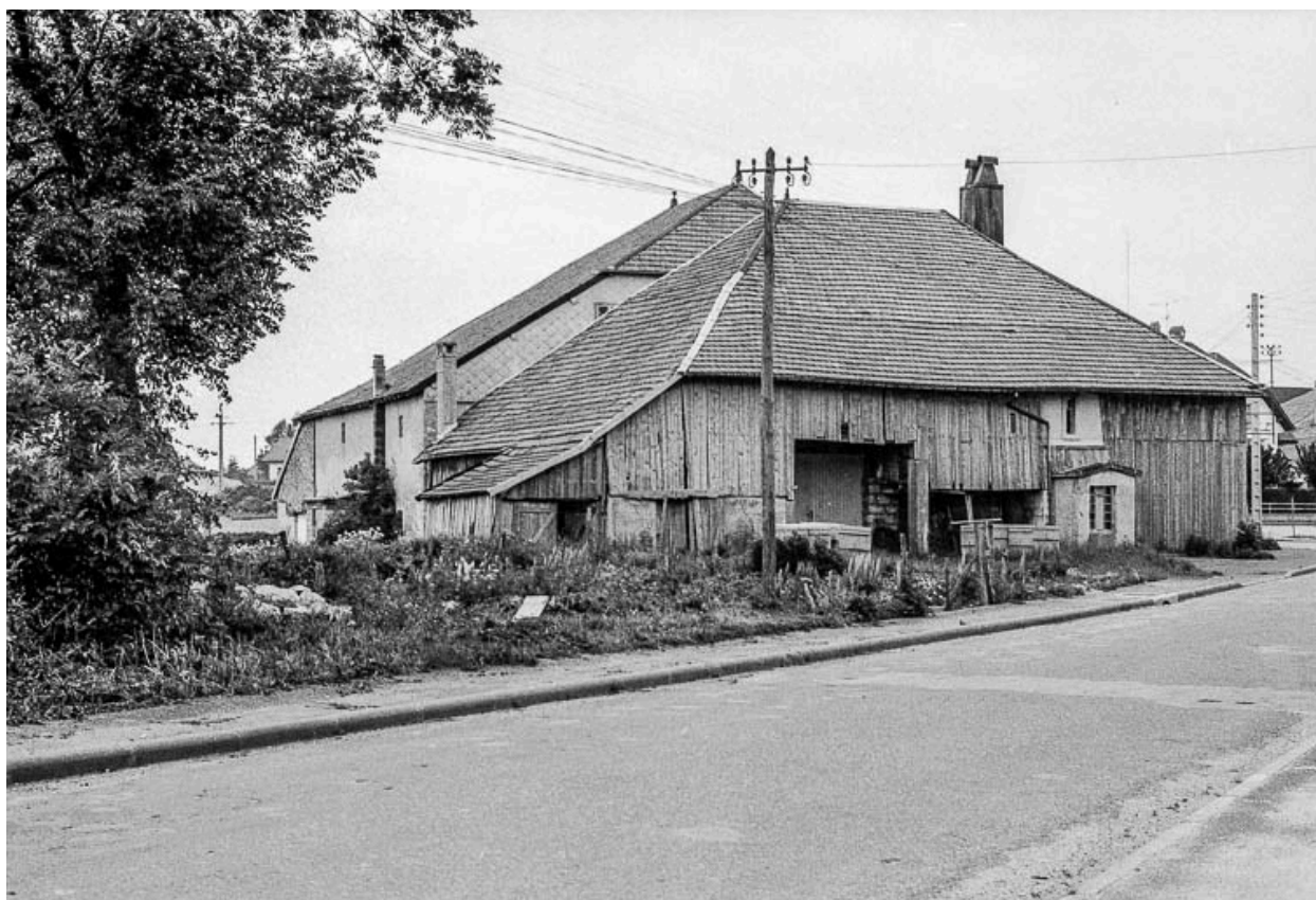
Ferme datée de 1797 : façade sur rue.
