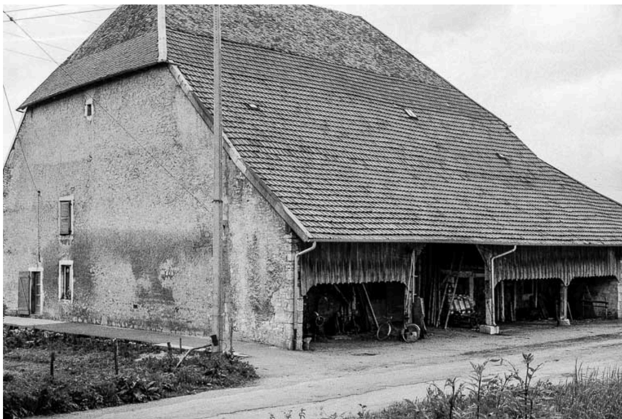
Ferme située rue du Moulin : vue du mur long-pan sur rue et façade latérale droite.
