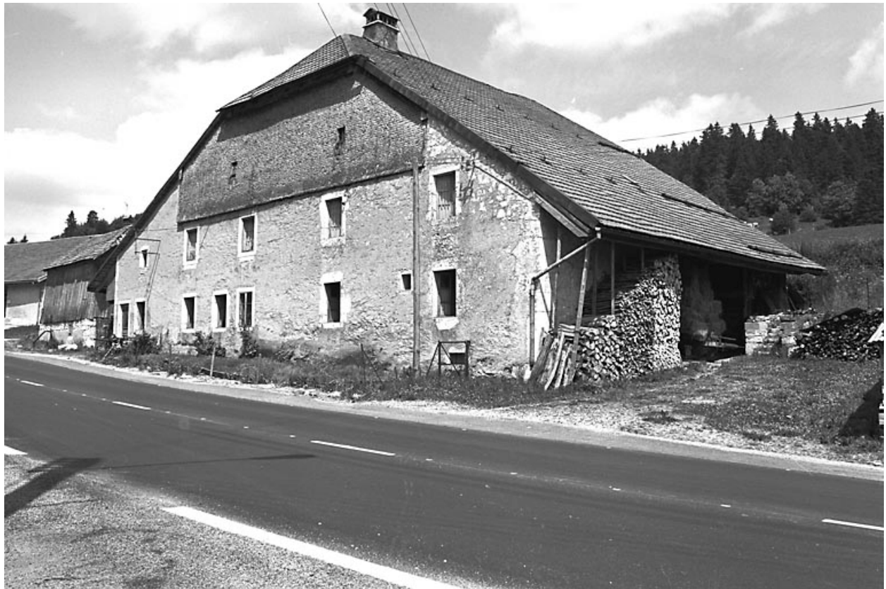
Les Hôpitaux-Neufs : grande ferme du 18 e siècle à toit à deux versants et petites croupes, pignon sur rue, de structure typique de la région (4 travées parallèles aux pignons. Une "montée de grange" contre le goutterot gauche, permet d'accéder à la "grange haute".
