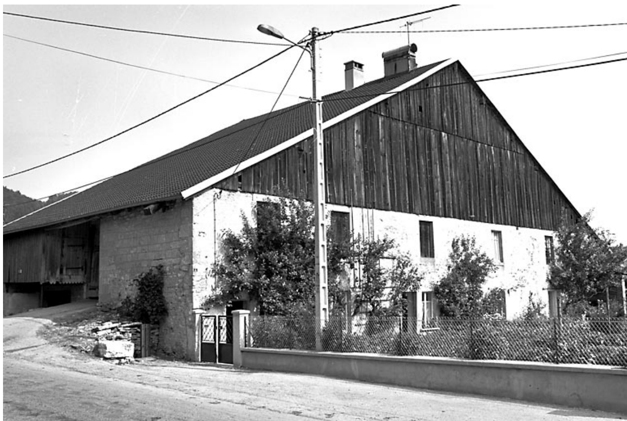
Dommartin : ferme située 4 rue de la Montagne. Le débord du toit sur rue protège les entrées de la "grange haute" et de l'étable.
