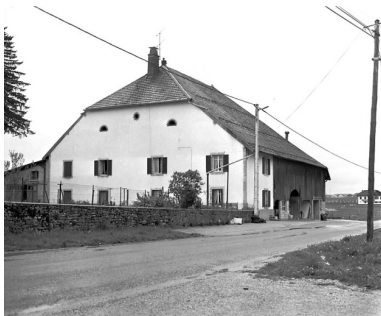
Bannans : ferme située rue Laurent Trouttet. Phot. Yves Sancey IVR43_19812500162X
