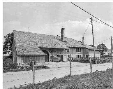
Bouverans : ferme située rue du Coin des Petits. Phot. Dominique Dominguez IVR43_19792500833X
