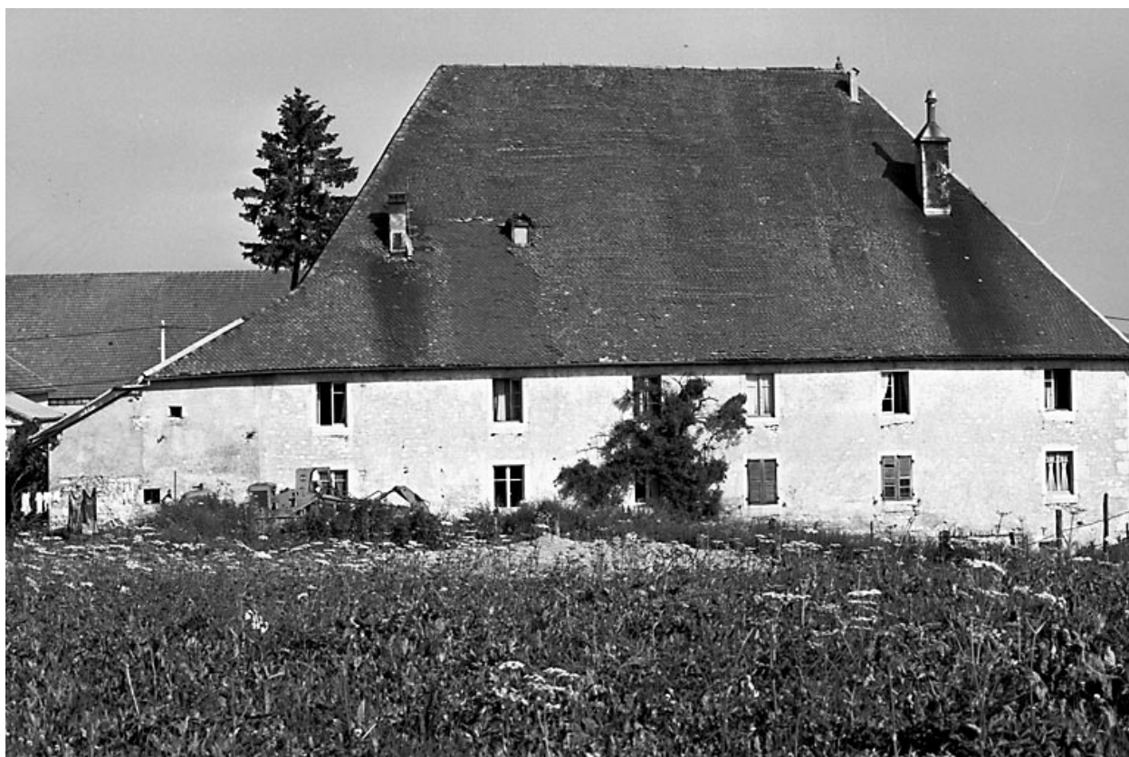
Ferme située à Sainte-Colombe.
