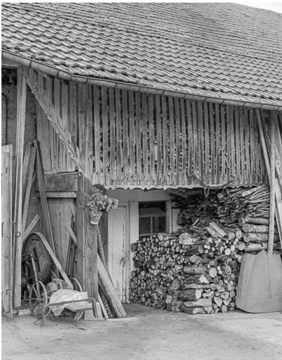
La Planée : galerie en bois contre un mur goutterot.
