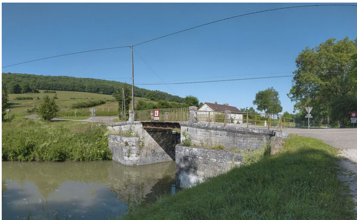
Pont vu d'aval.
