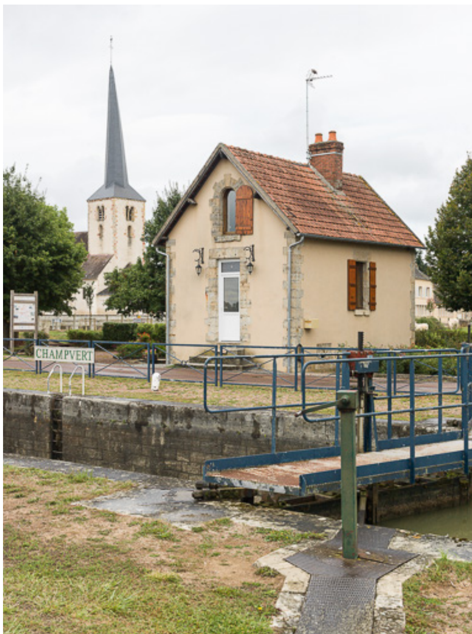
Le sas et la maison éclusière.
