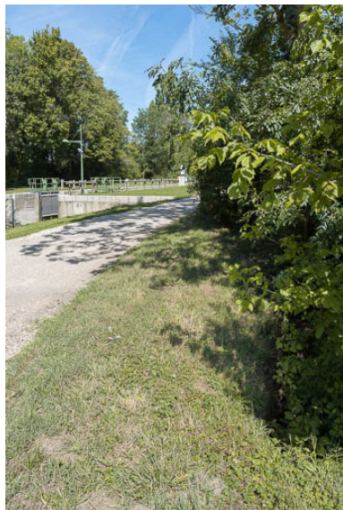
Vue de l'aqueduc.
