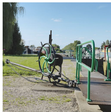
Détail du mécanisme des portes du sas. Phot. Thierry Kuntz IVR26_20112103346NUC4A
