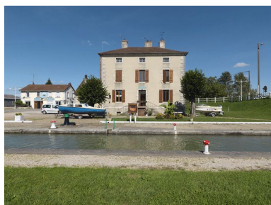
Maison éclusière vue de face. Phot. Thierry Kuntz IVR26_20112103342NUC4A
