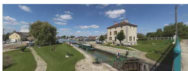
Ensemble du site vu d'aval. Phot. Thierry Kuntz IVR26_20112103341NUC4A
