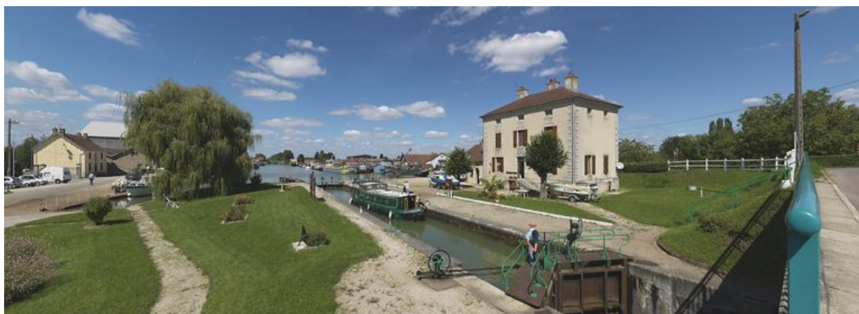
Ensemble du site vu d'aval.
