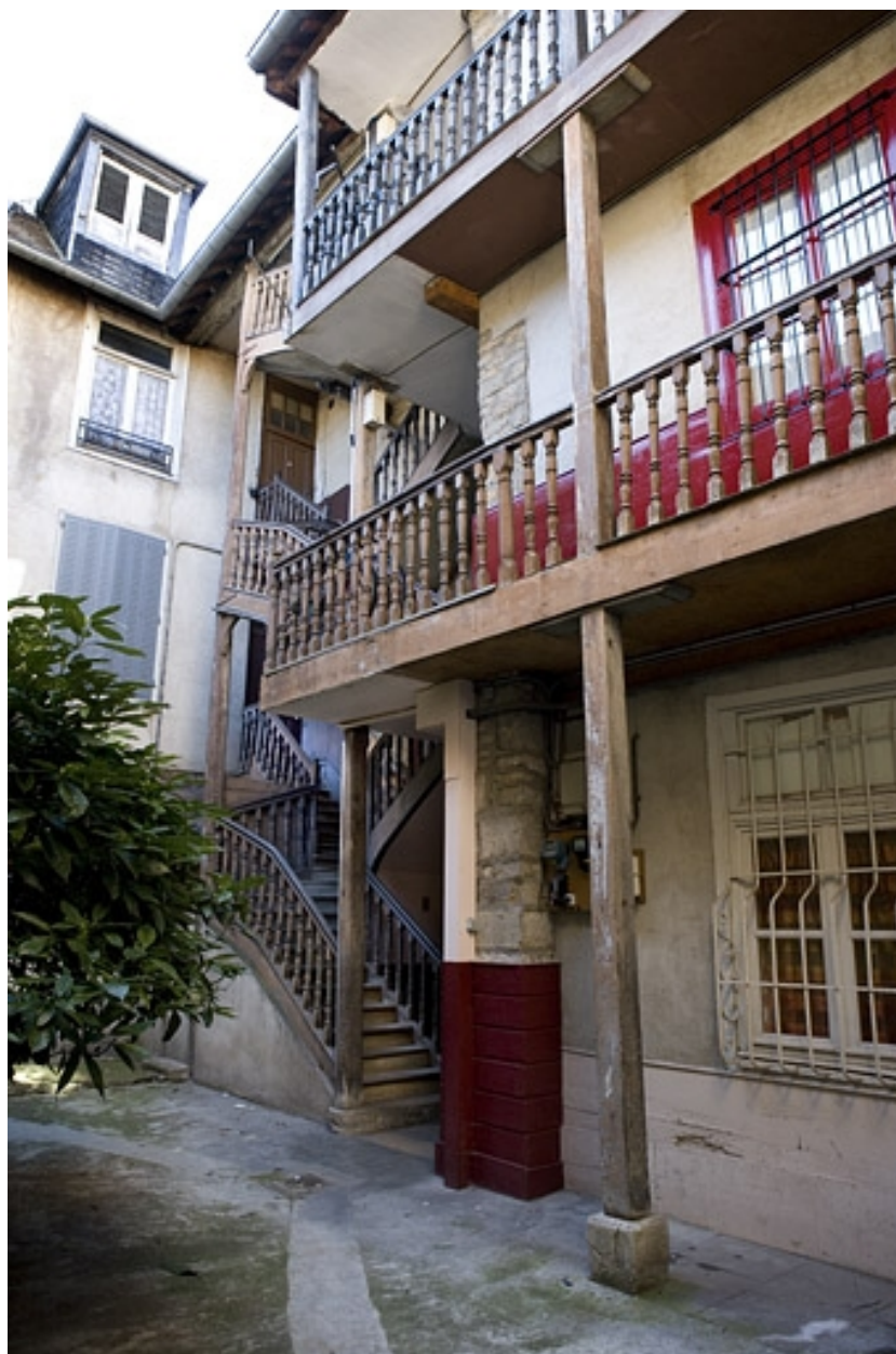
Vue d'ensemble de l'escalier à cage ouverte et des coursières depuis la cour.
