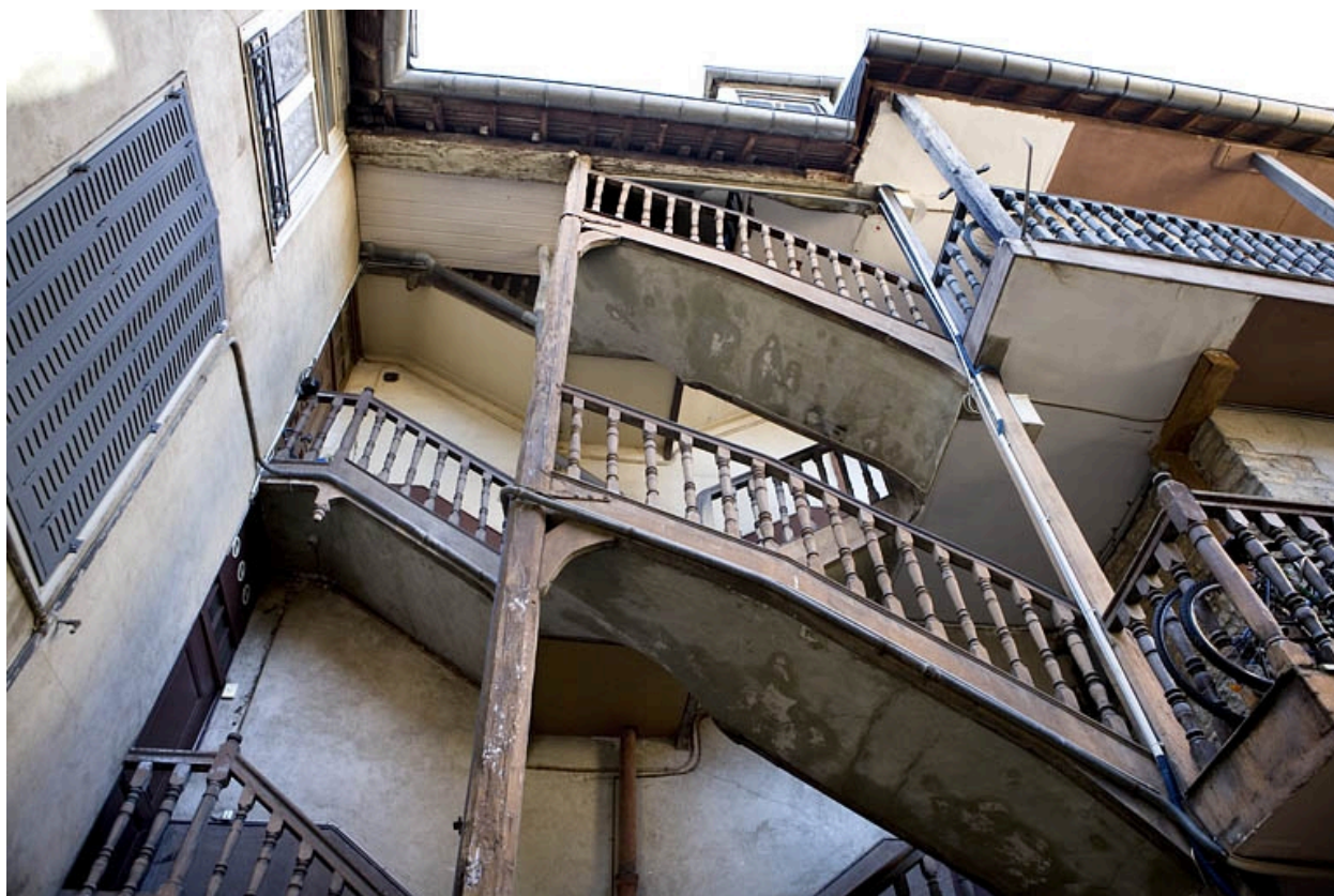
Détail de l'escalier à cage ouverte.
