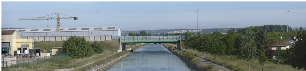
Vue d'ensemble (prise d'amont).
