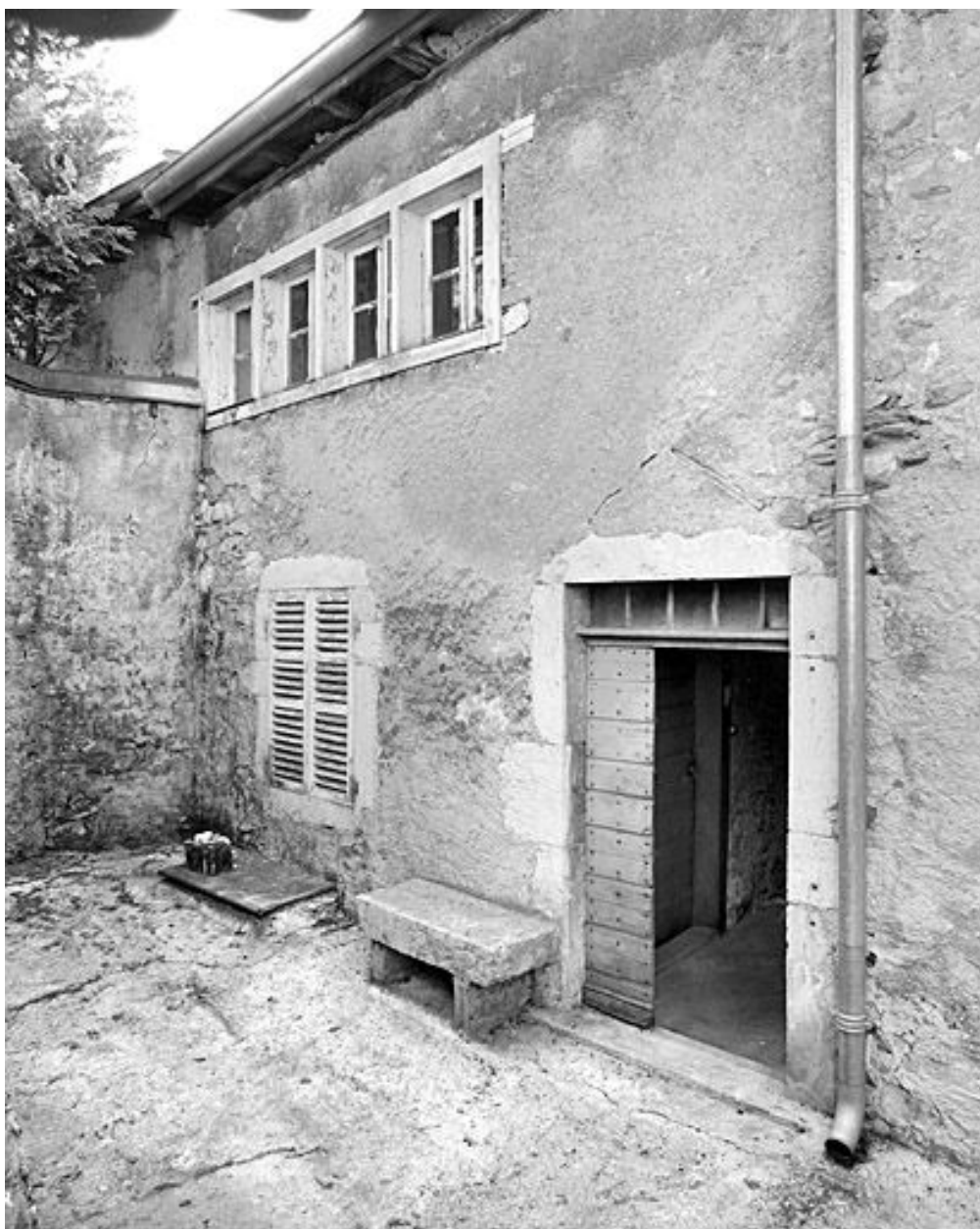
Façade postérieure du bâtiment oriental.
