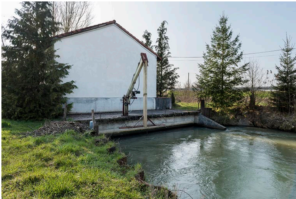
Appareil lié à l'entretien du bief.
