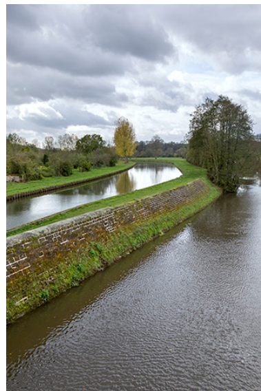
La dérivation construite latéralement à la rivière. Phot. Sonia Dourlot IVR43_20157000187NUC2A
