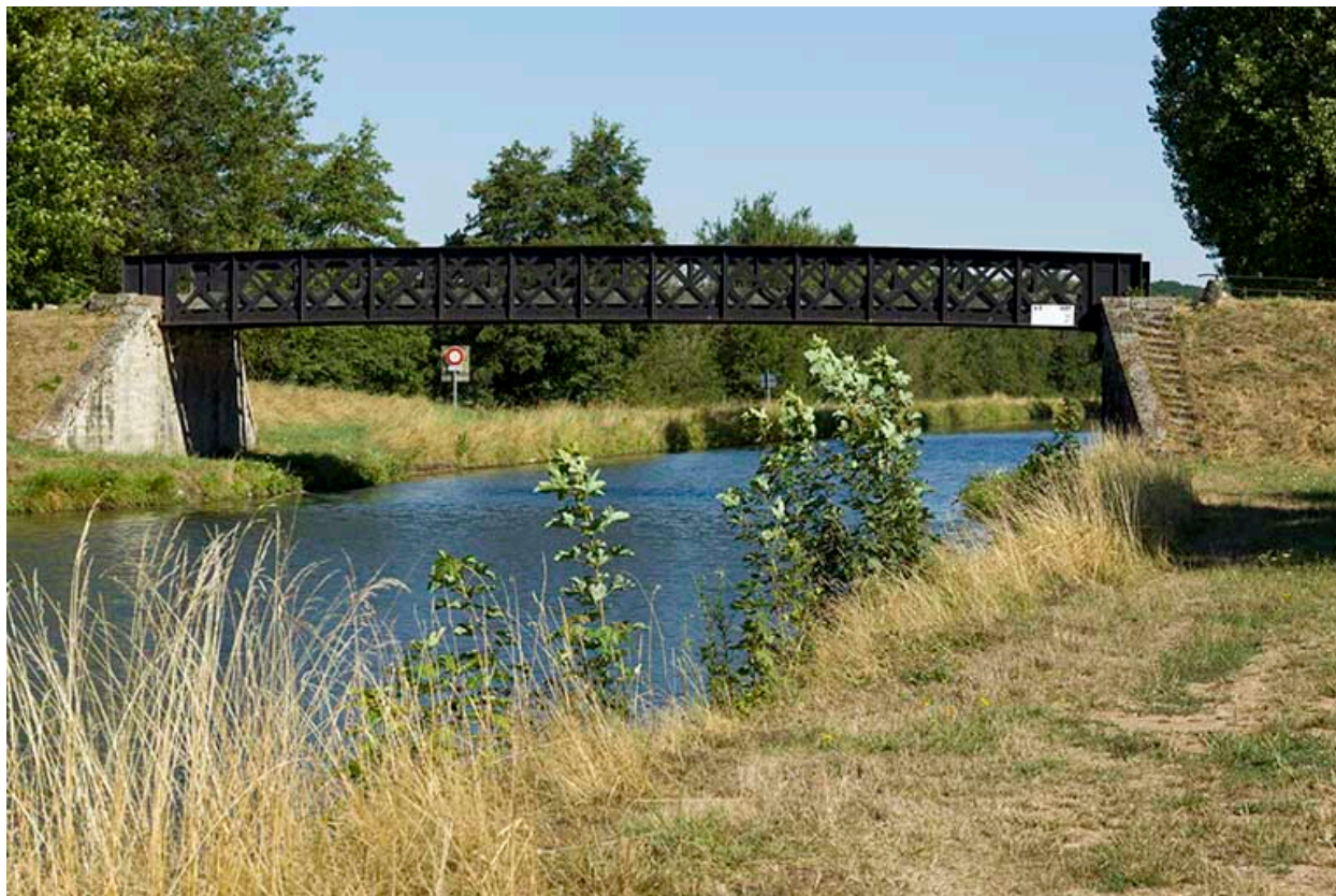
Le pont depuis l'aval.
