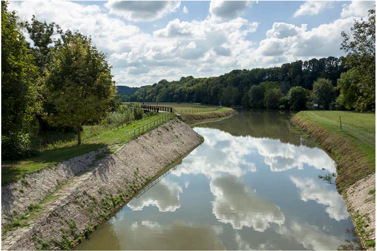
Vue aval depuis l'écluse n°46 du canal des Vosges et la Saône en arrière-plan.
