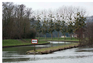
Entrée du canal de navigation d'Ormoy. Phot. Sonia Dourlot IVR43_20167000272NUC4A
