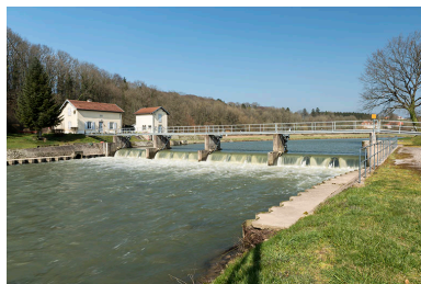
Le site du barrage mobile, vue d'ensemble. Phot. Sonia Dourlot IVR43_20167000274NUC4A
