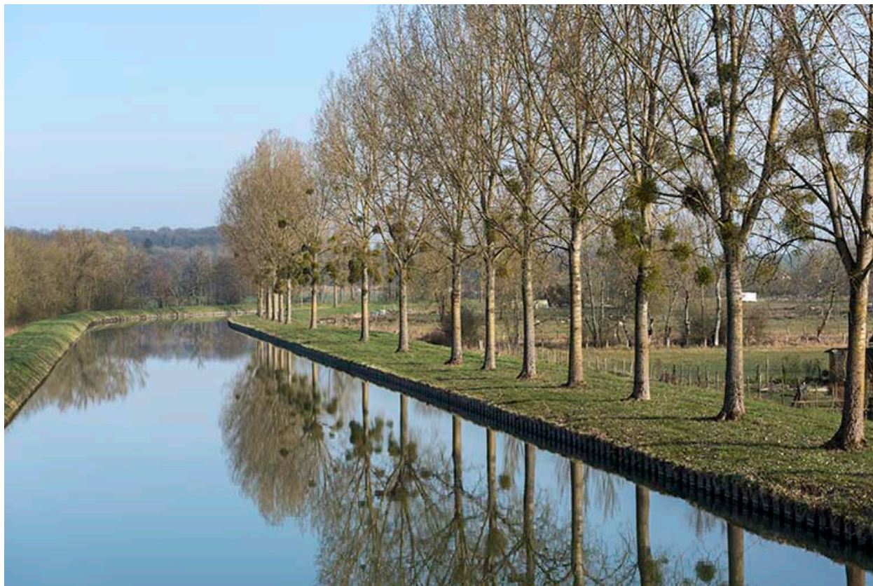
Le canal, vue vers l'amont.
