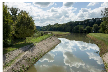
Vue aval depuis l'écluse n°46 du canal des Vosges et la Saône en arrière-plan. Phot. Sonia Dourlot IVR43_20157000973NUC2A
