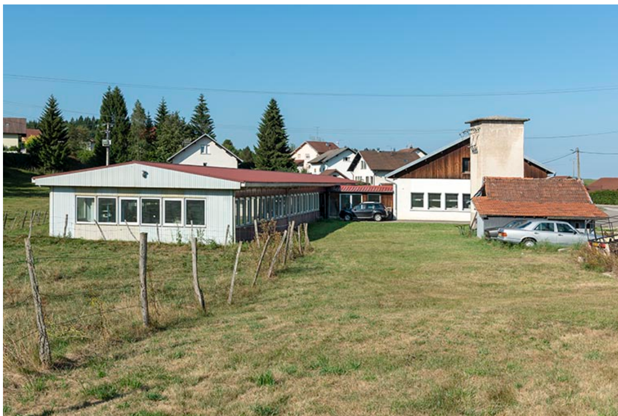
Façade latérale gauche.
