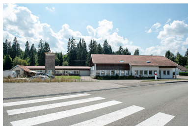
Vue d'ensemble, depuis le nord. Phot. Sonia Dourlot IVR43_20182501784NUC4A
