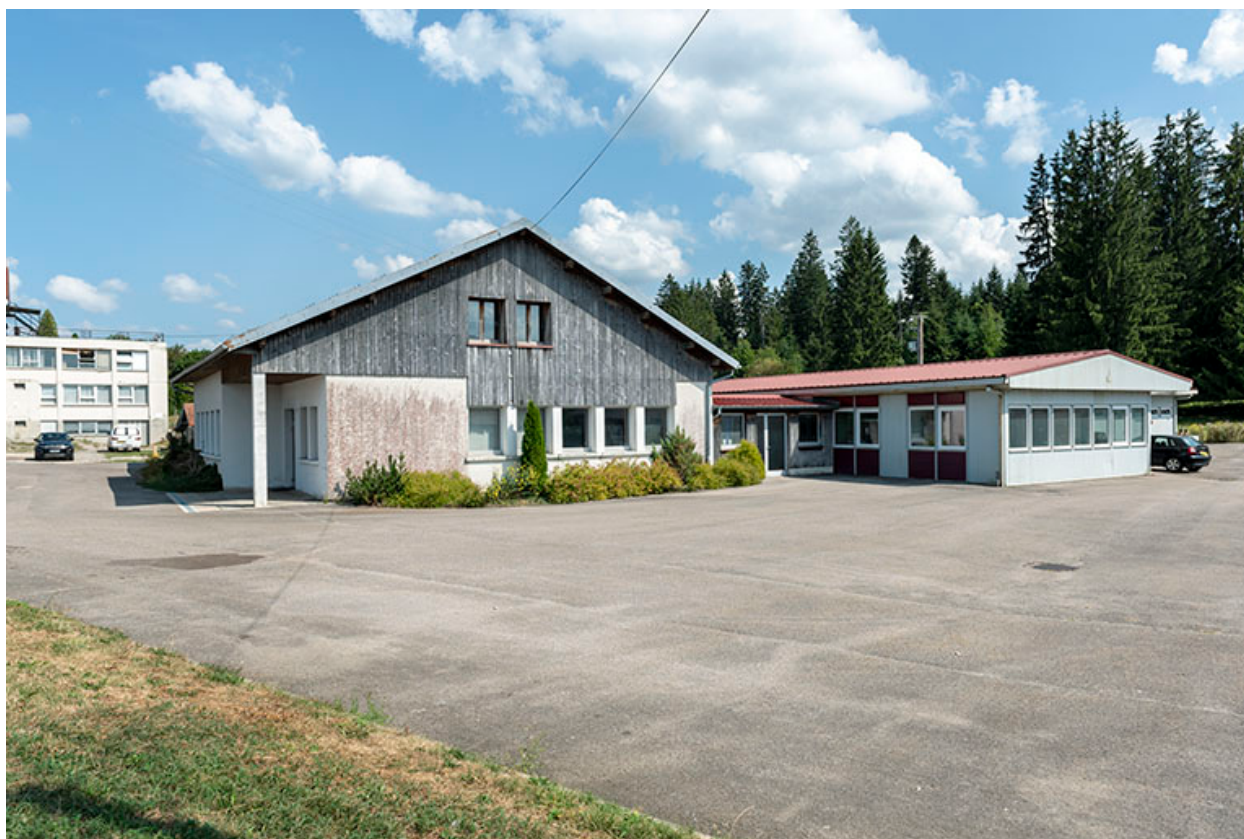
Façade latérale droite, de trois quarts gauche.
