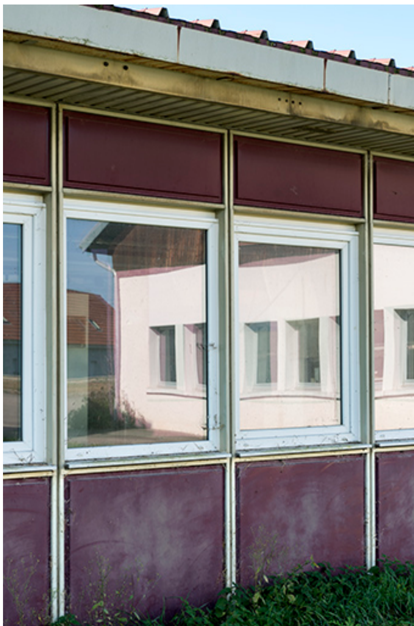
Deux travées de la façade antérieure.
