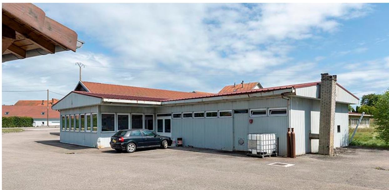
Façade latérale droite, de trois quarts droite.
