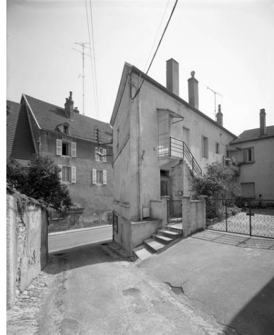
Façade postérieure. Phot. Yves Sancey IVR43_19917000057V
