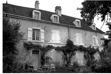
Façade antérieure. Phot. Dominique Dominguez IVR43_19807000178X
