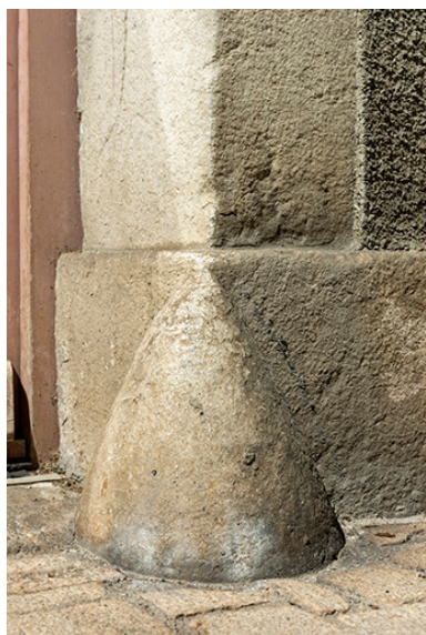
Immeuble 2 rue Jacques Courtois : chasse-roue. Phot. Sonia Dourlot IVR43_20192501477NUC4A
