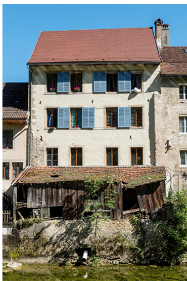
Immeuble 3 place du Chapître : façade postérieure. Phot. Sonia Dourlot IVR43_20192501485NUC4A
