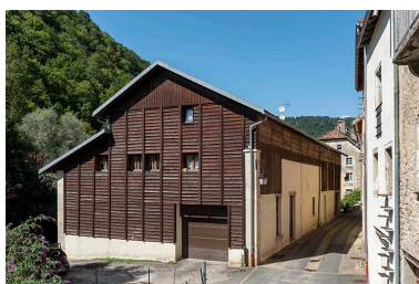
Tannerie : façades postérieure et latérale gauche.
