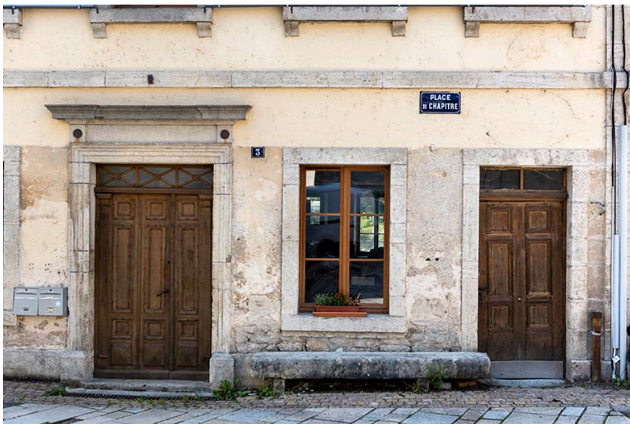
Immeuble 3 place du Chapitre, façade antérieure : entrée.
