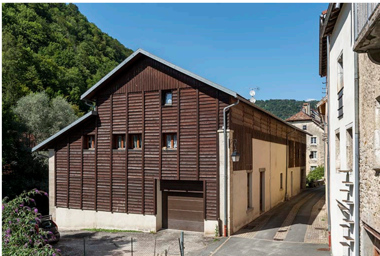
Tannerie : façades postérieure et latérale gauche.
