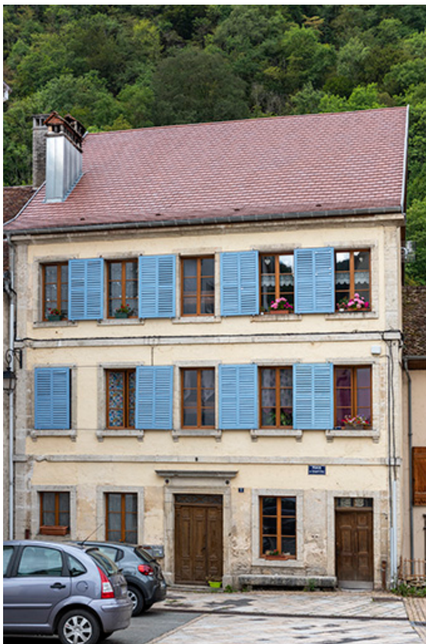
Immeuble 3 place du Chapitre : façade antérieure.
