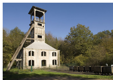
Le chevalement. Vue d'ensemble depuis l'ouest. Phot. Jérôme Mongreville IVR43_20067000969NUCA
