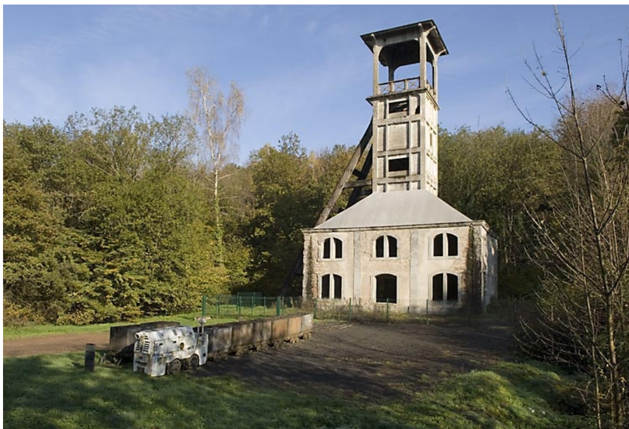
Le chevalement. Vue d'ensemble depuis le sud-ouest.
