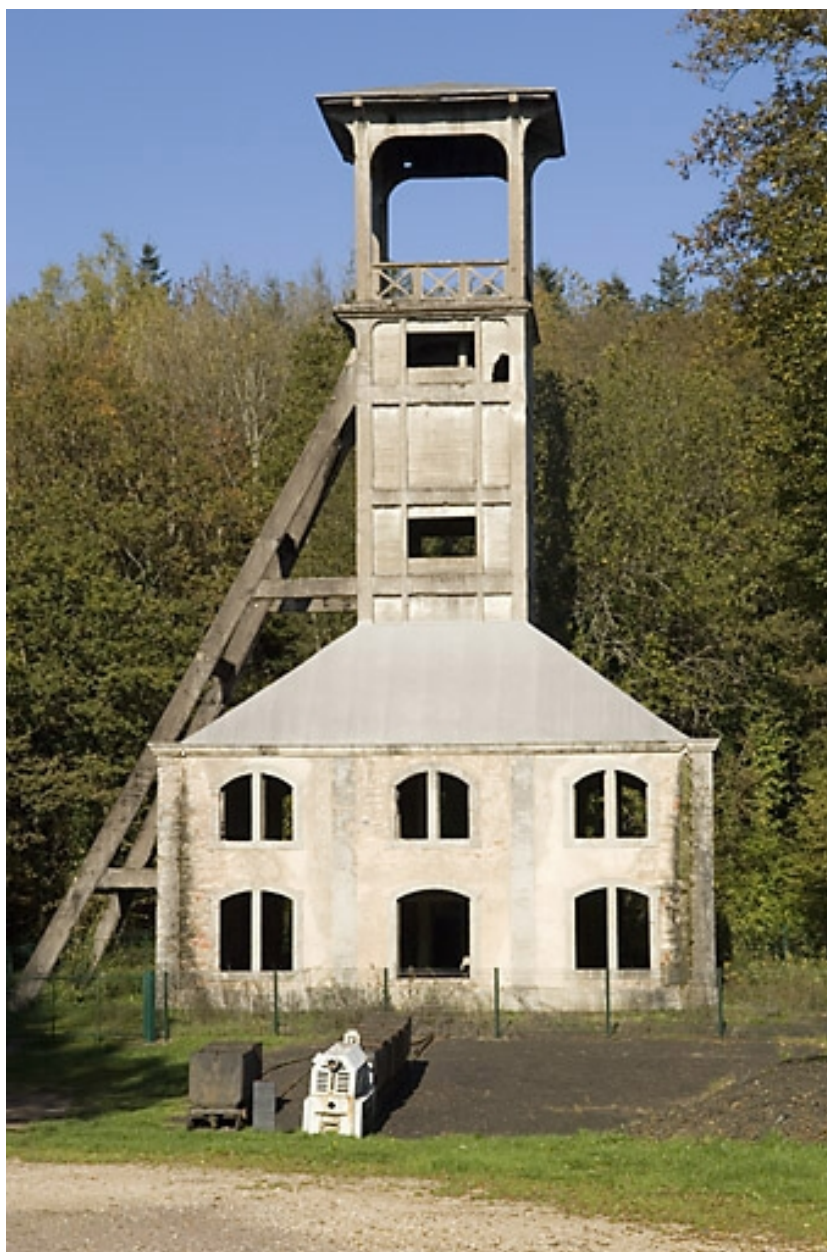
Le chevalement vu de face. Vue rapprochée.
