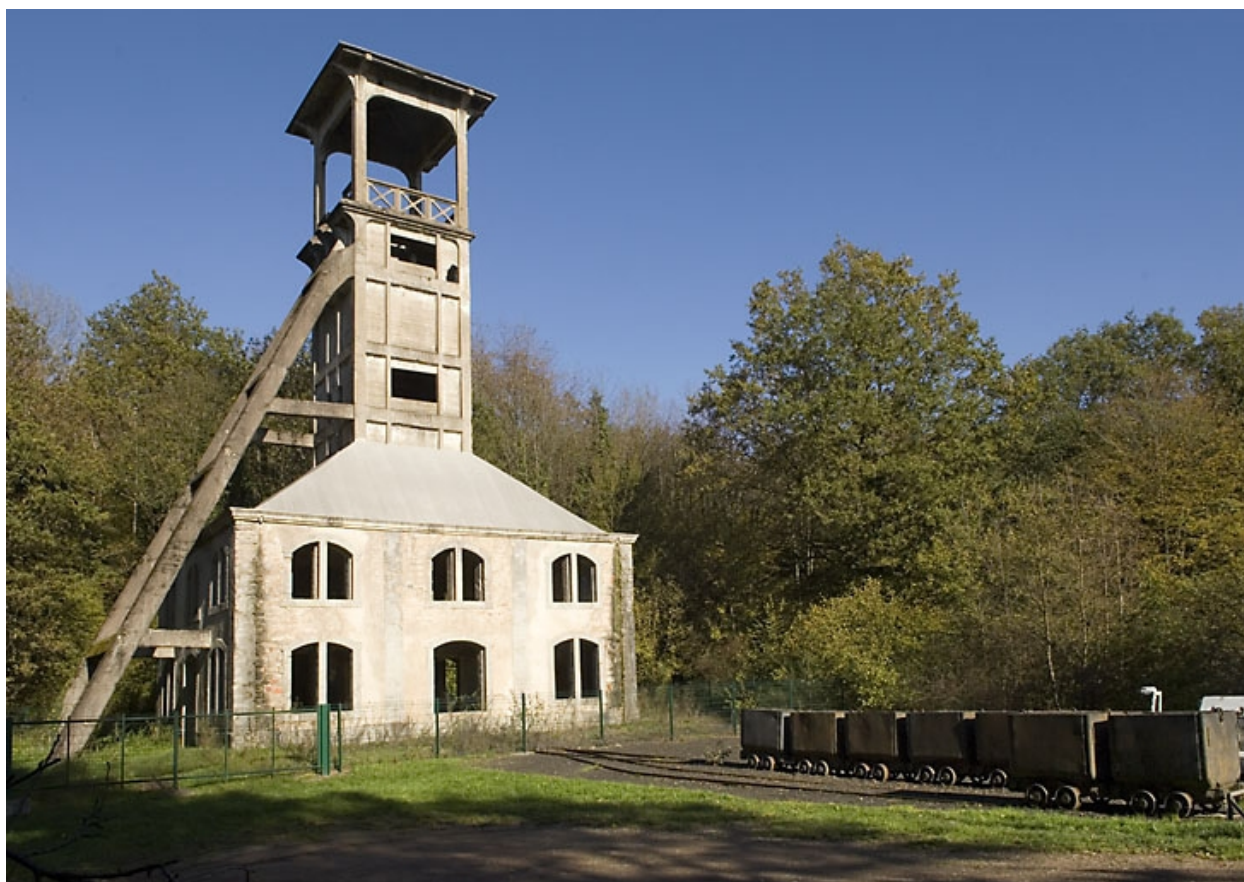
Le chevalement. Vue d'ensemble depuis l'ouest.
