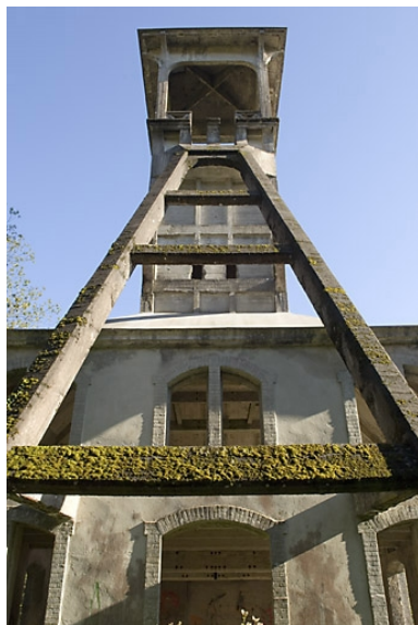
Le chevalement. Vue en contre-plongée. Phot. Jérôme Mongreville IVR43_20067000972NUCA
