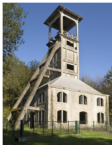
Le chevalement. Vue de trois quarts. Phot. Jérôme Mongreville IVR43_20067000970NUCA
