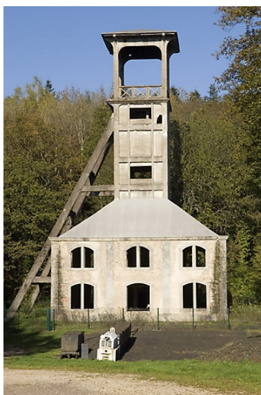
Le chevalement vu de face. Vue rapprochée. Phot. Jérôme Mongreville IVR43_20067000971NUCA
