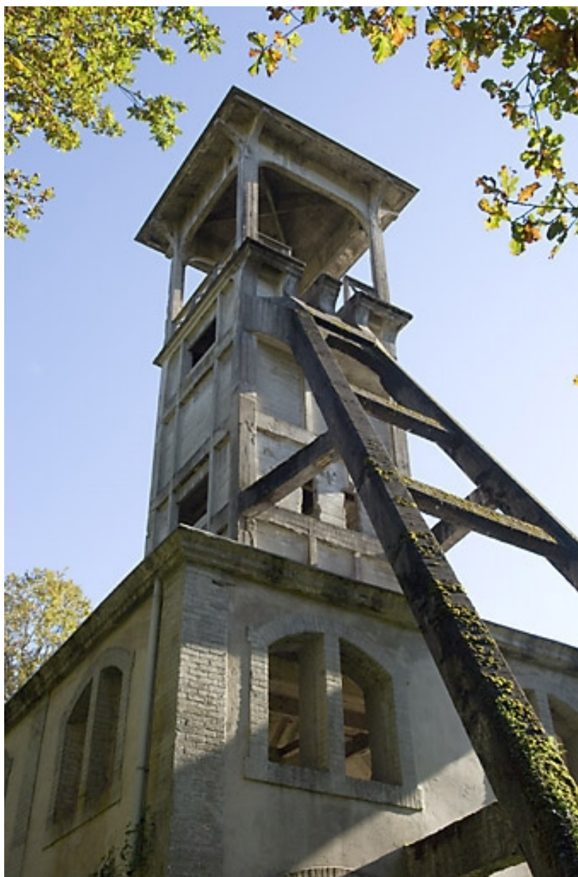
Le chevalement. Détail de la partie supérieure.
