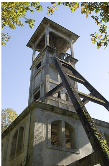
Le chevalement. Détail de la partie supérieure. Phot. Jérôme Mongreville IVR43_20067000973NUCA
