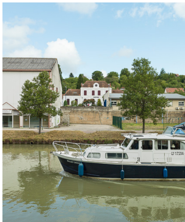
Vue de la gare et du canal. Phot. Pierre-Marie Barbe-Richaud IVR26_20175800238NUC2A
