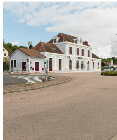
Vue de la gare. Phot. Pierre-Marie Barbe-Richaud IVR26_20175800239NUC2A
