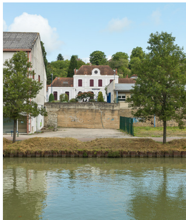
Vue de la gare et du canal. Phot. Pierre-Marie Barbe-Richaud IVR26_20175800237NUC2A
