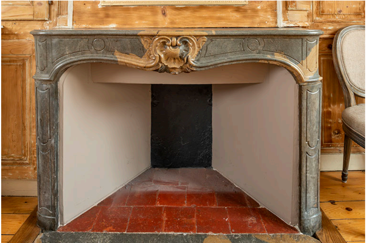
Cheminé de la chambre (second étage).
