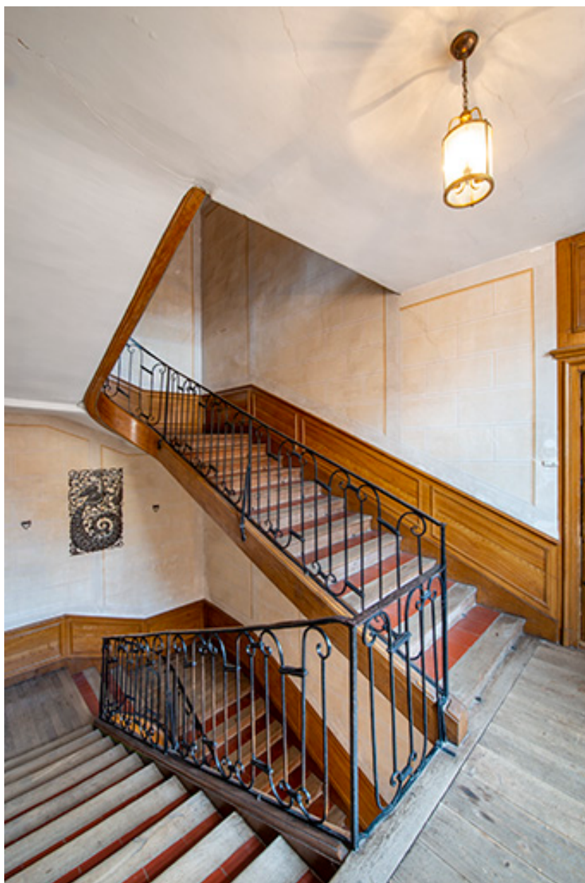
Vue de l'escalier depuis le palier du deuxième étage.
