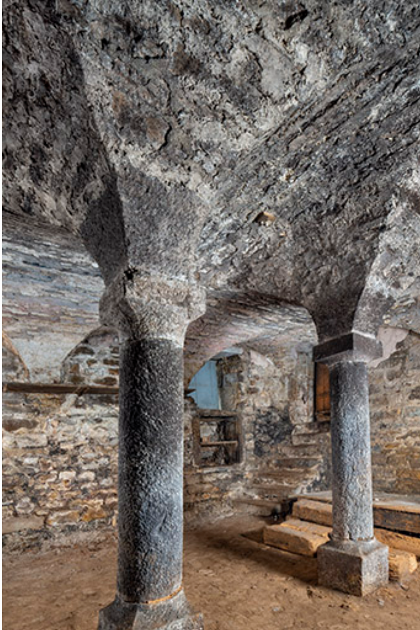
Vue d'ensemble de la cave depuis le sud.
