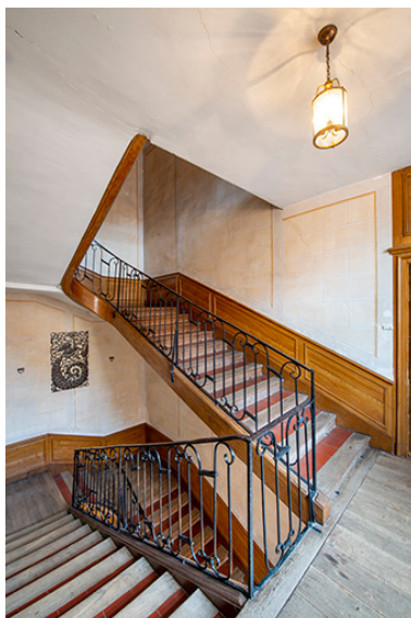
Vue de l'escalier depuis le palier du deuxième étage. Phot. Jérôme Mongreville IVR43_20223901058NUC4A
