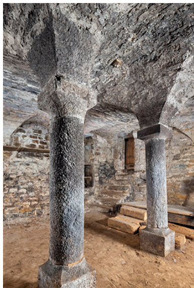
Vue de la cave depuis le sud. Phot. Jérôme Mongreville IVR43_20223901051NUC4A
