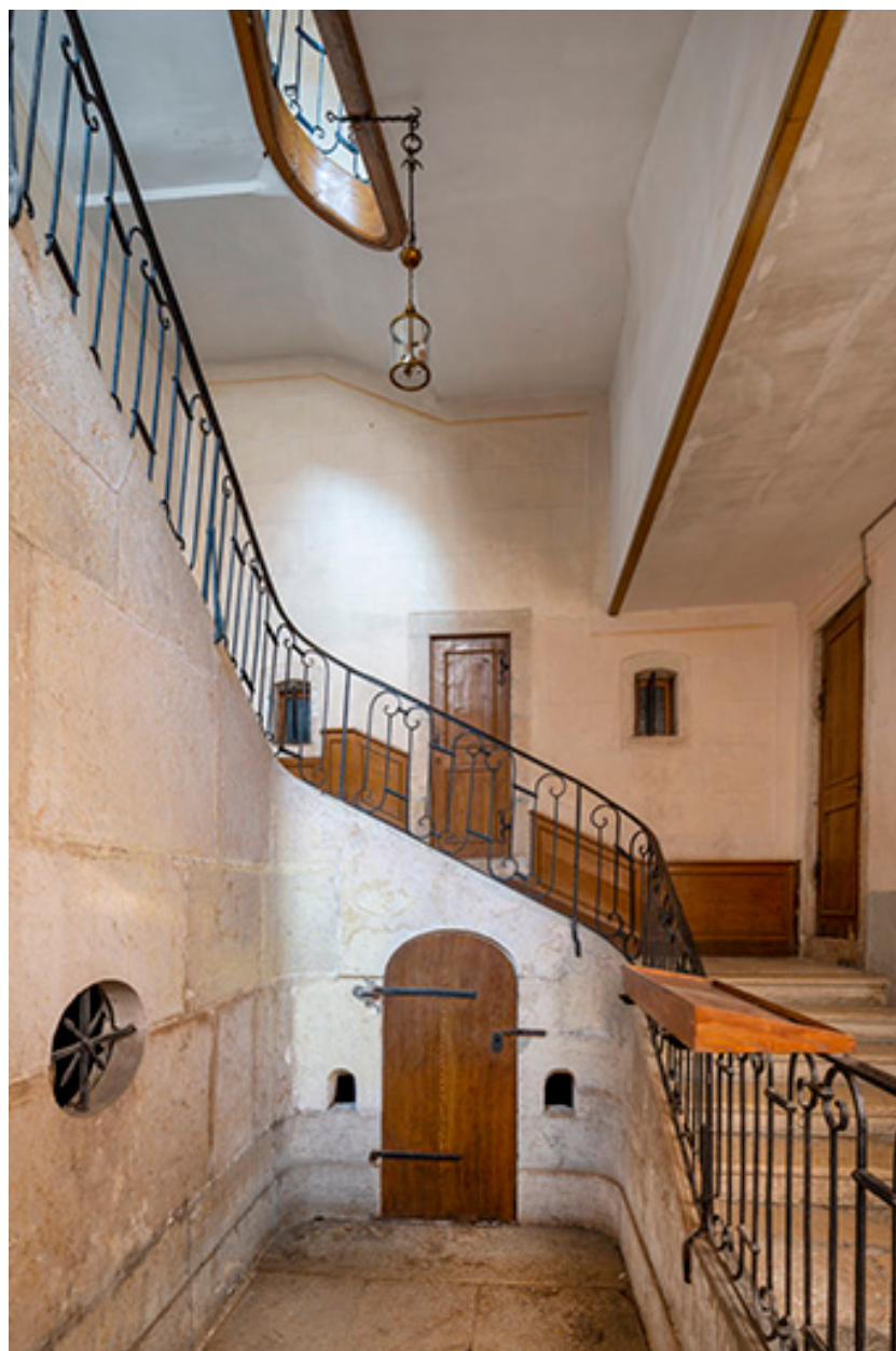
Escalier. Vue axiale depuis le rez-de-chaussée.
