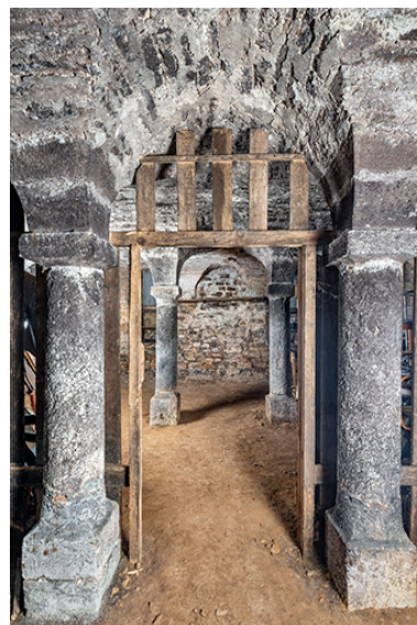
Vue axiale de la cave. Phot. Jérôme Mongreville IVR43_20223901050NUC4A
