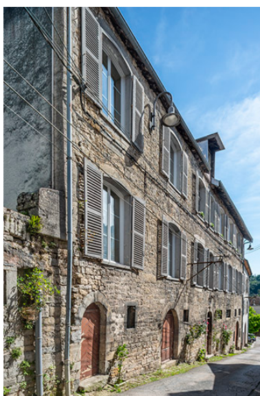
Façade antérieure vue de trois quarts gauche. Phot. Jérôme Mongreville IVR43_20233900983NUC4A
