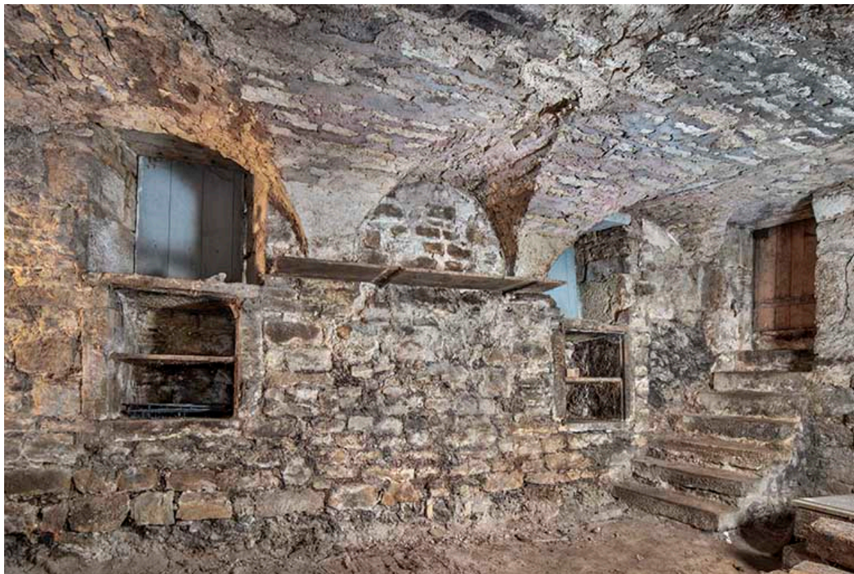
Mur ouest (sur la rue du Chambenoz) de la cave.
