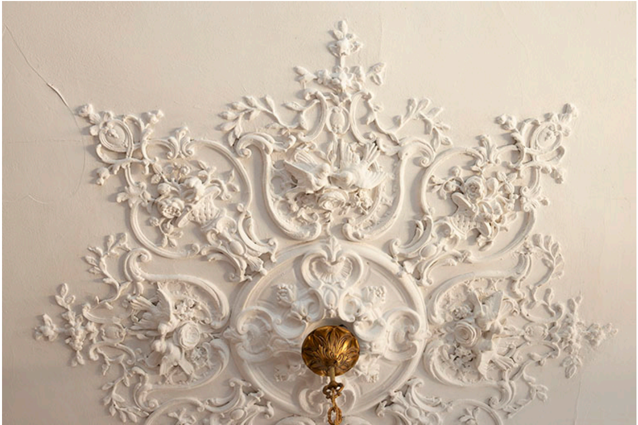
Salon du second étage. Rosace de plafond.
