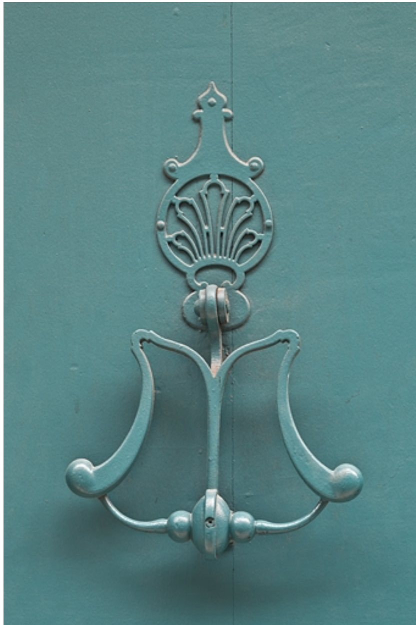
Portail d'entrée : détail du heurtour.
