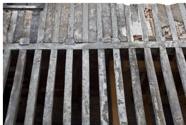
Bûcher : détail des pans de bois.
