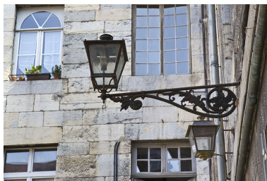
Cour : détail d'un bec de gaz. Phot. Yves Sancey IVR43_20112500845NUC2A
