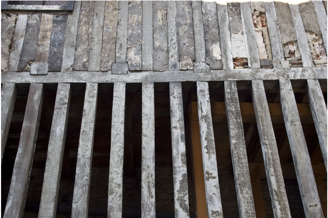
Bûcher : détail des pans de bois.
