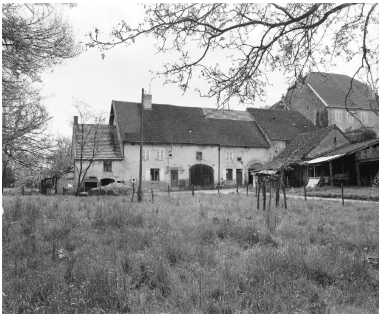
Ferme située chemin de la Butte (?) : vue d'ensemble.
