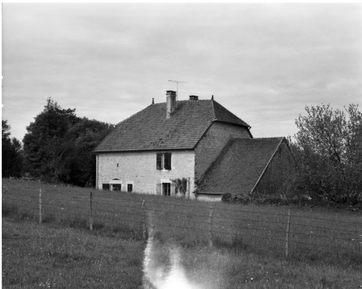
Ferme située chemin de la Muyre : vue d'ensemble.
