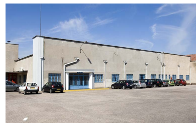
Façade des bureaux. Phot. Jérôme Mongreville IVR43_20097000319NUC2A
