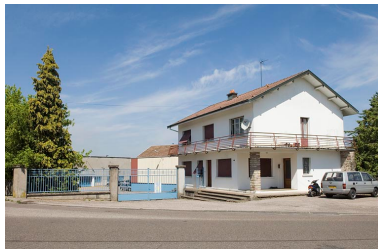
Ancien accès de l'usine et conciergerie. Phot. Jérôme Mongreville IVR43_20097000324NUC2A
