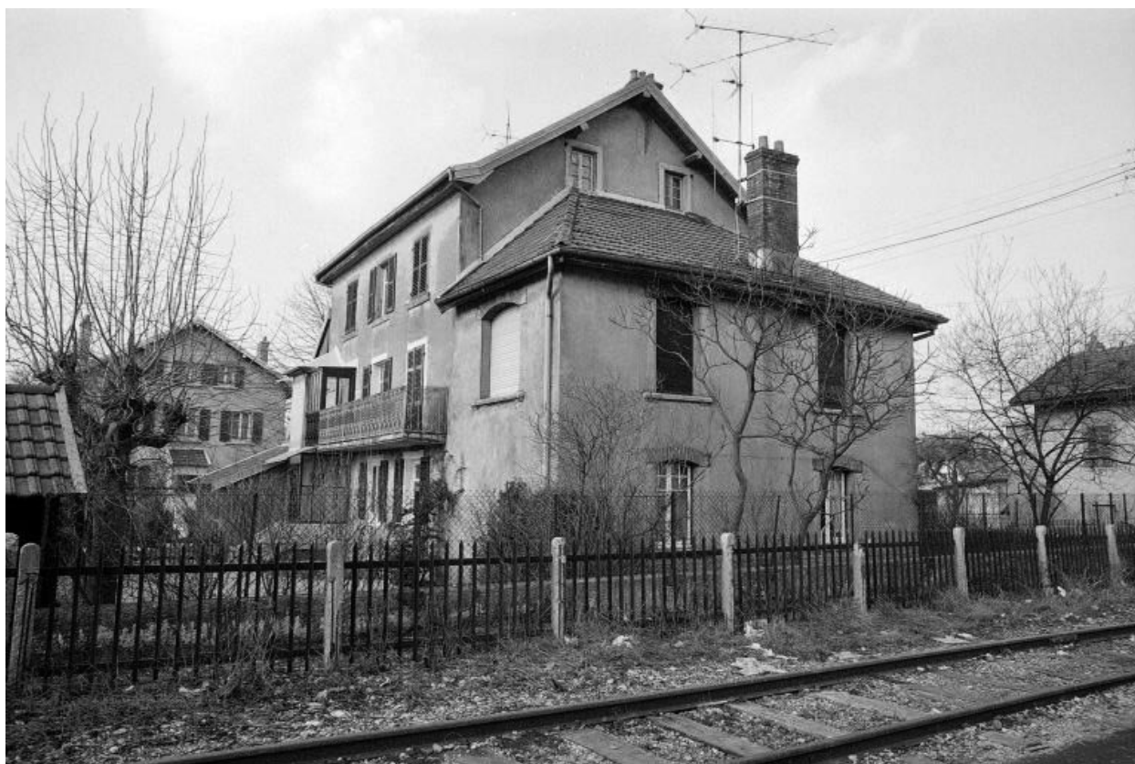
Façades antérieure et latérale gauche.
