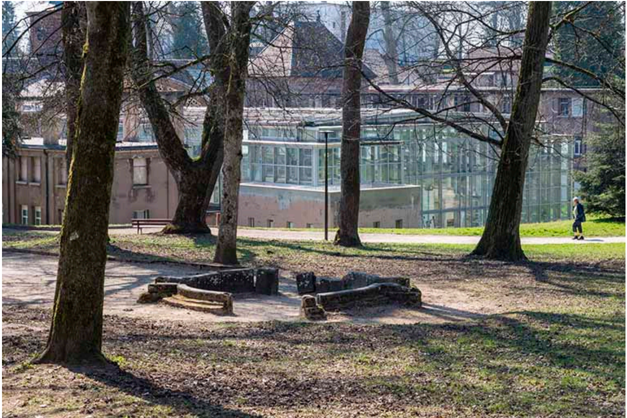
Éléments de la margelle de la piscine déposés dans le parc thermal.
