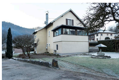
Façades postérieure et latérale gauche.
