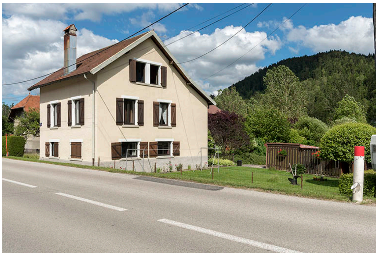
Façades antérieure et latérale droite.
