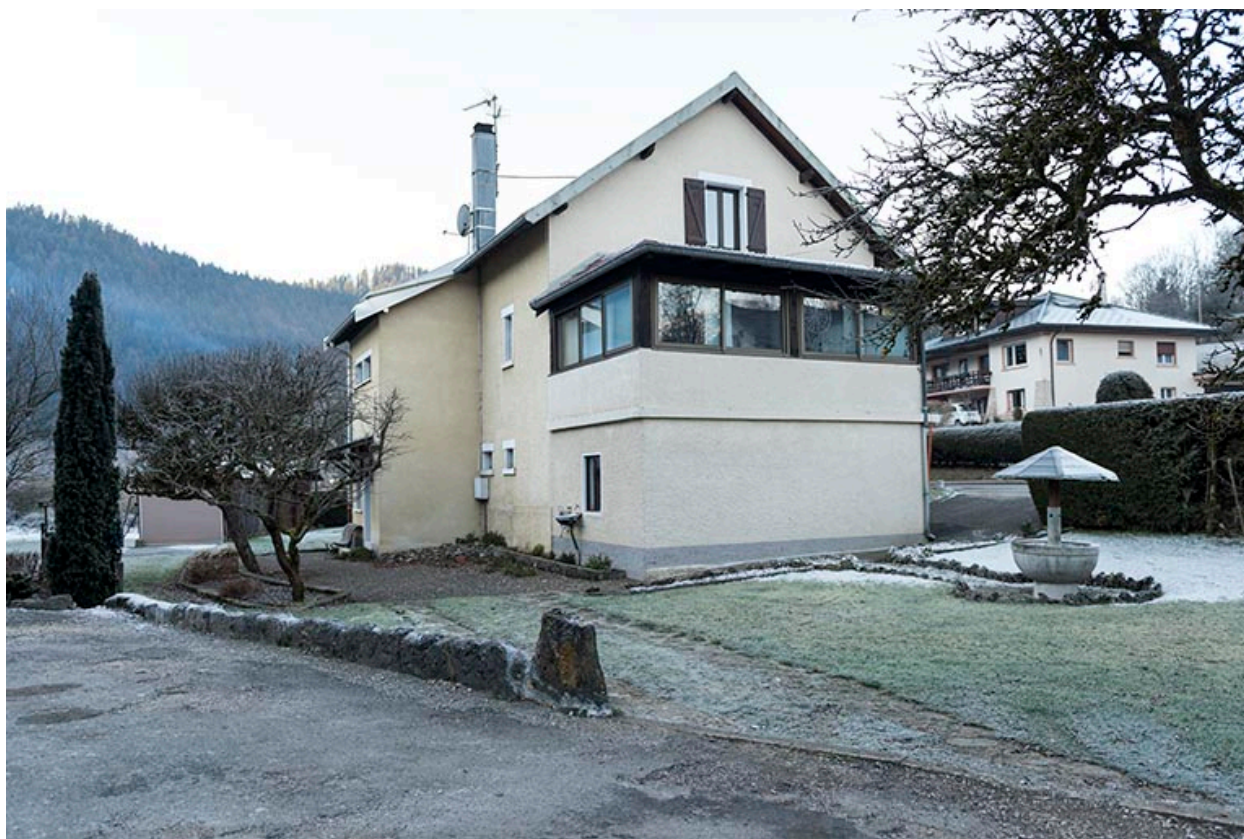
Façades postérieure et latérale gauche.
