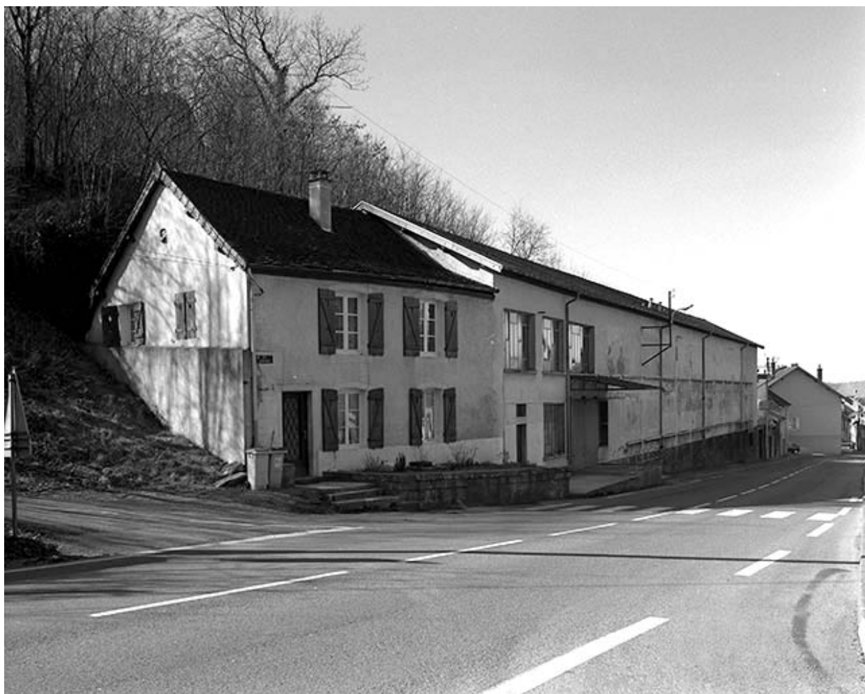
Logement, bureau et atelier de fabrication.
