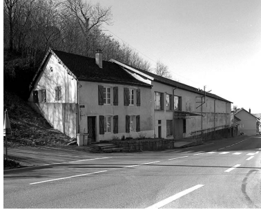
Logement, bureau et atelier de fabrication.
