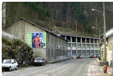
Façades antérieure et latérale gauche.
