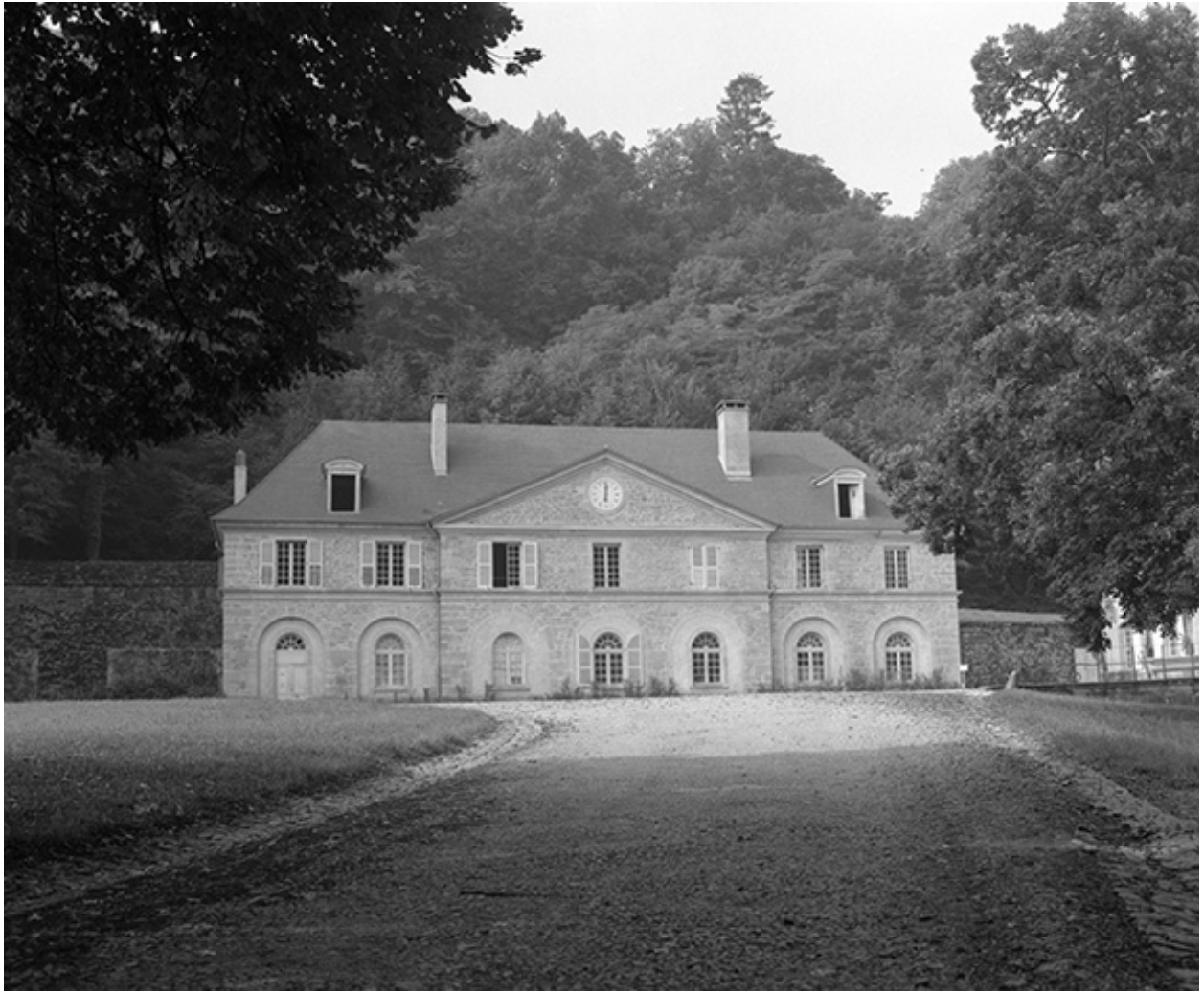
Pavillon gauche, façade antérieure en 1979.
