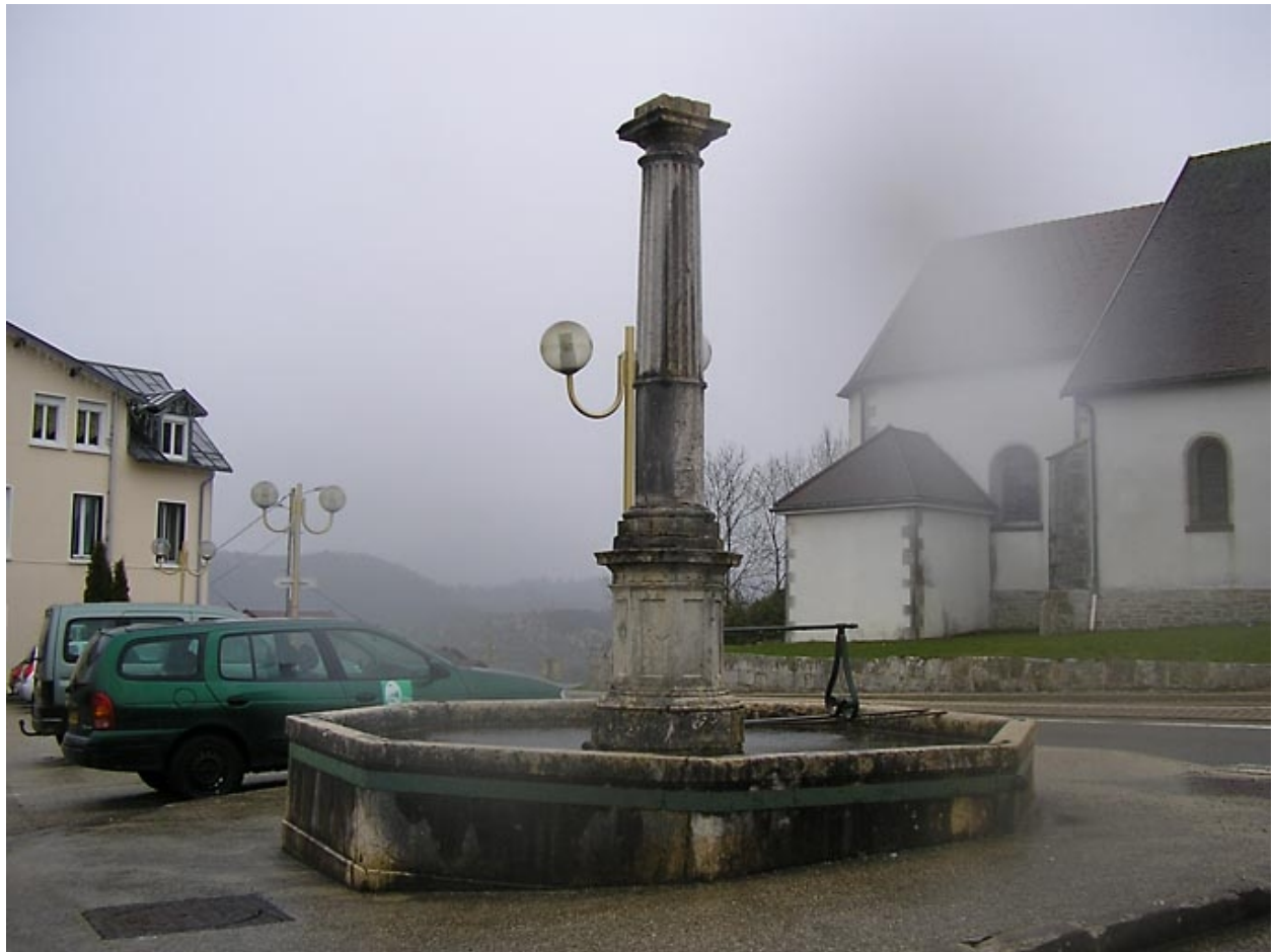
Vue générale sur ensemble hydraulique.
