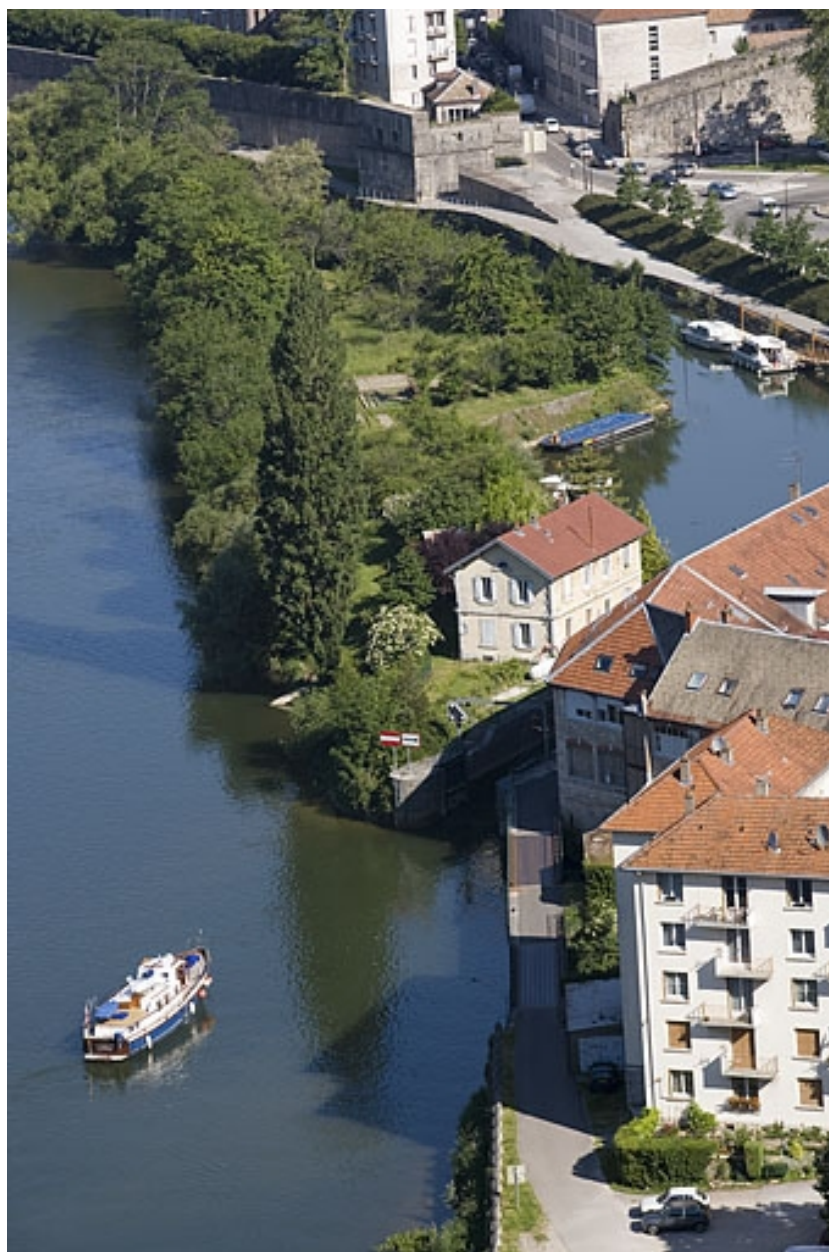
Vue d'ensemble plongeante, depuis l'aval.
