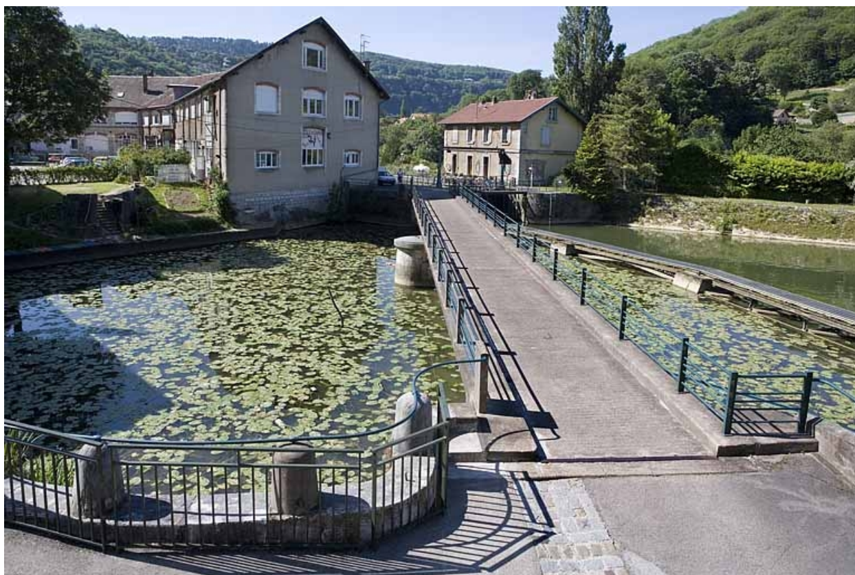
Vue d'ensemble, depuis l'amont.
