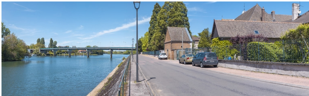
Vue d'ensemble du pont, depuis l'aval.
