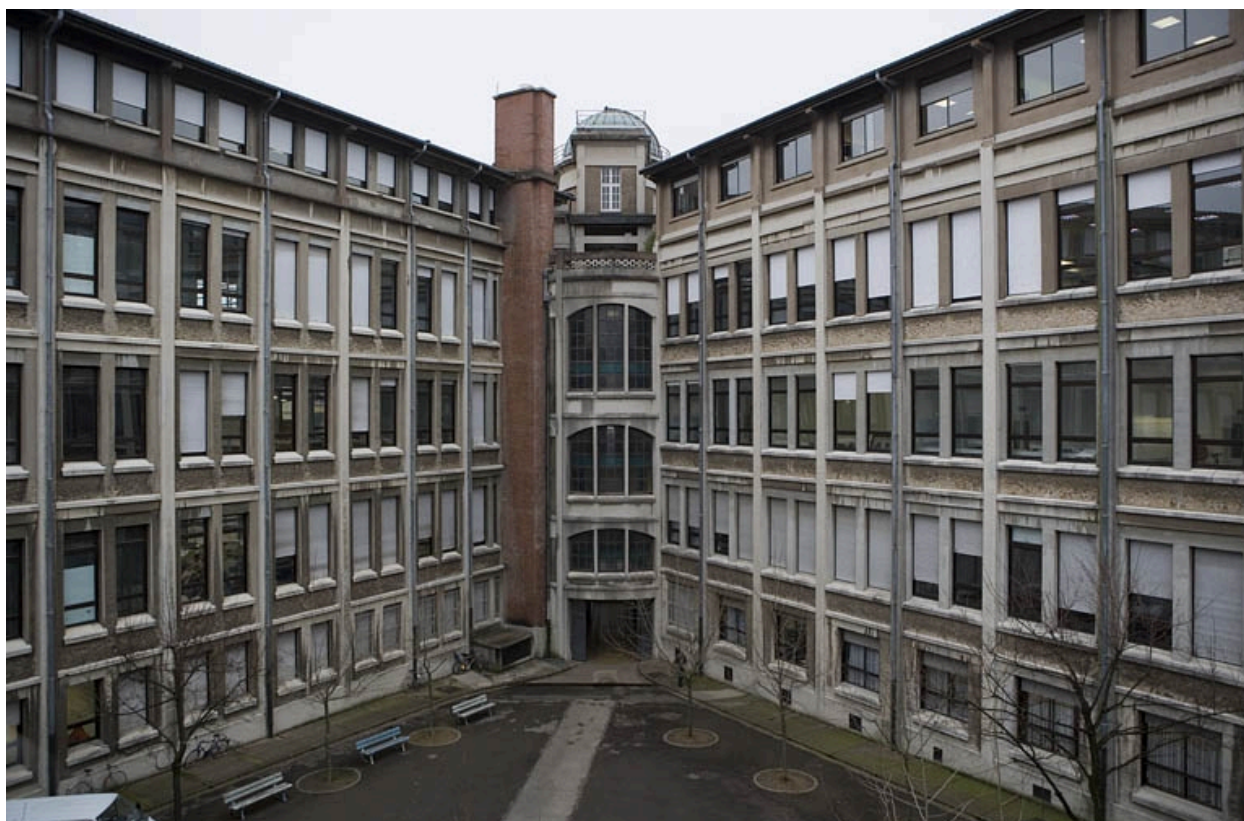
Ailes nord et sud : façades sur cour à leur jonction.
