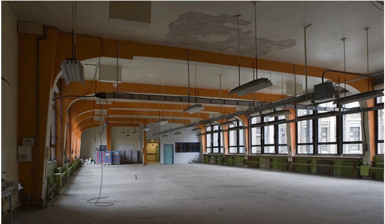
Traverse, atelier microtechnique 150 (1er étage) en 2007 avant rénovation : vue d'ensemble.
