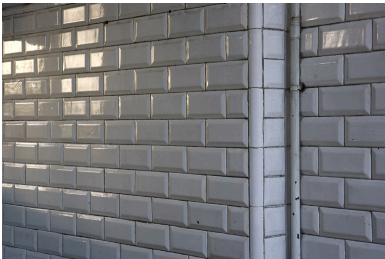
Aile nord, atelier de mécanique 190 (1er étage) : carrelage mural des sanitaires.
