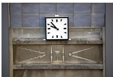
Traverse : horloge et décor marquant l'axe central (vue rapprochée). Le sablier symbolise l'horlogerie, les éclairs l'électricité et le compas la mécanique. Phot. Yves Sancey IVR43_20092501485NUC2A
