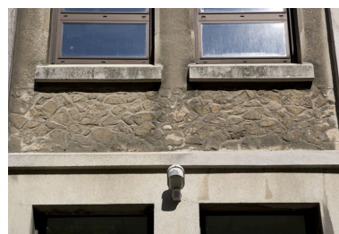
Aile nord : allège d'une baie. Phot. Yves Sancey IVR43_20092501488NUC2A
