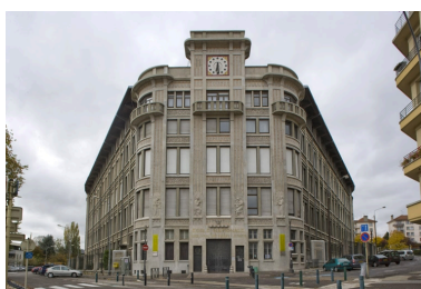
Corps d'entrée. Phot. Yves Sancey IVR43_20092501495NUC2A
