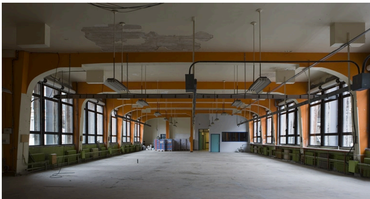
Traverse, atelier microtechnique (1er étage) : structure porteuse en béton. Atelier microtechnique 150 en 2007, avant rénovation.
