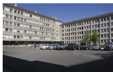
Internat : vue d'ensemble depuis la cour. Phot. Yves Sancey IVR43_20092501481NUC2A
