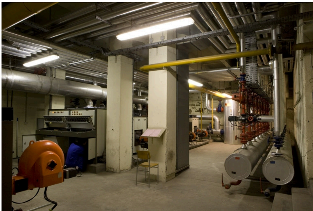
Corps d'entrée, chaufferie : vue d'ensemble.
