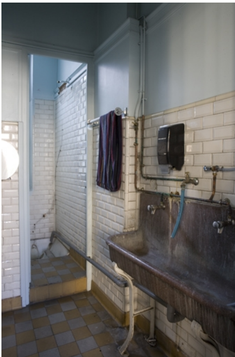
Aile nord, atelier de mécanique 190 (1er étage) : sanitaires.
