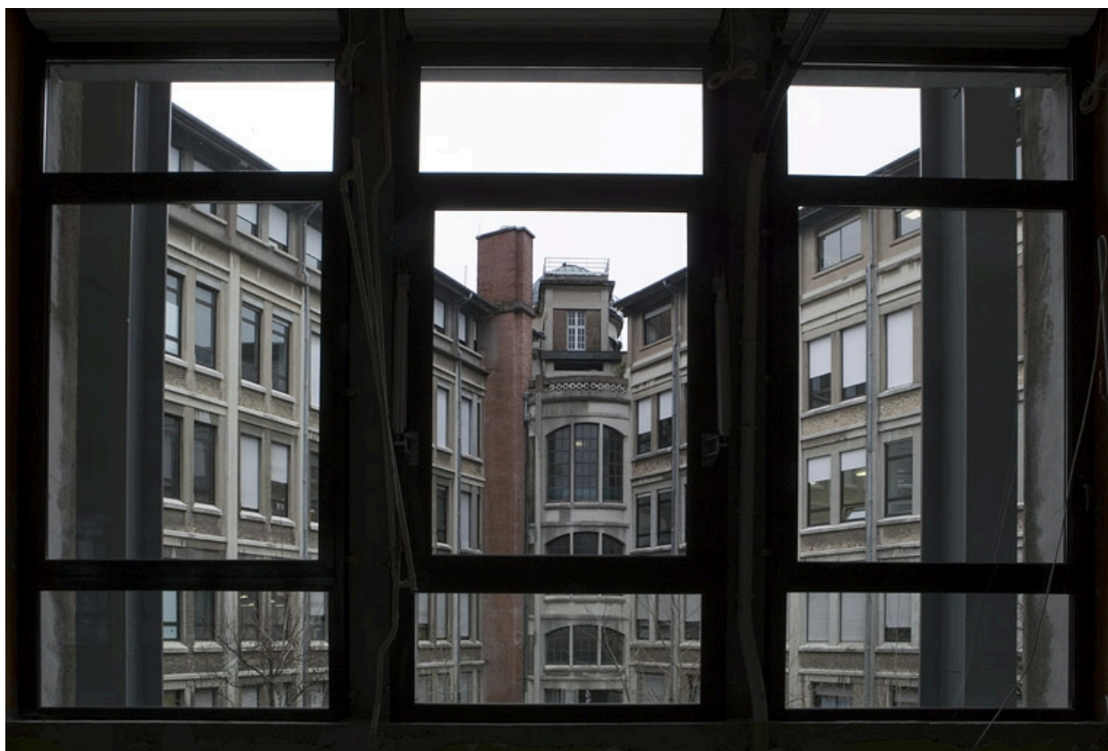
Traverse, atelier microtechnique (1er étage) : baie, avec vue sur la partie supérieure du corps d'entrée. Atelier microtechnique en 2007, avant rénovation.
