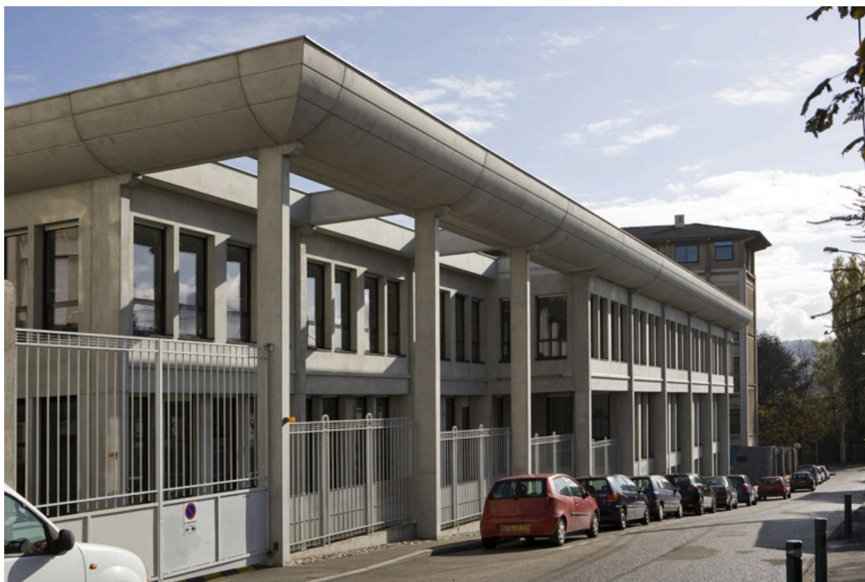
Bâtiment Coste, de trois quarts gauche.
