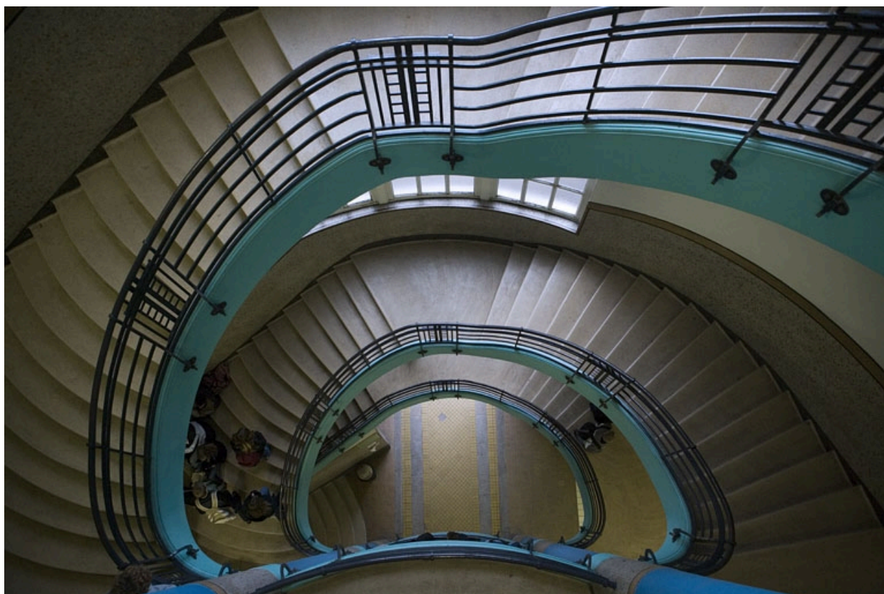
Corps d'entrée, grand escalier : vue plongeante depuis le palier du 3e étage
