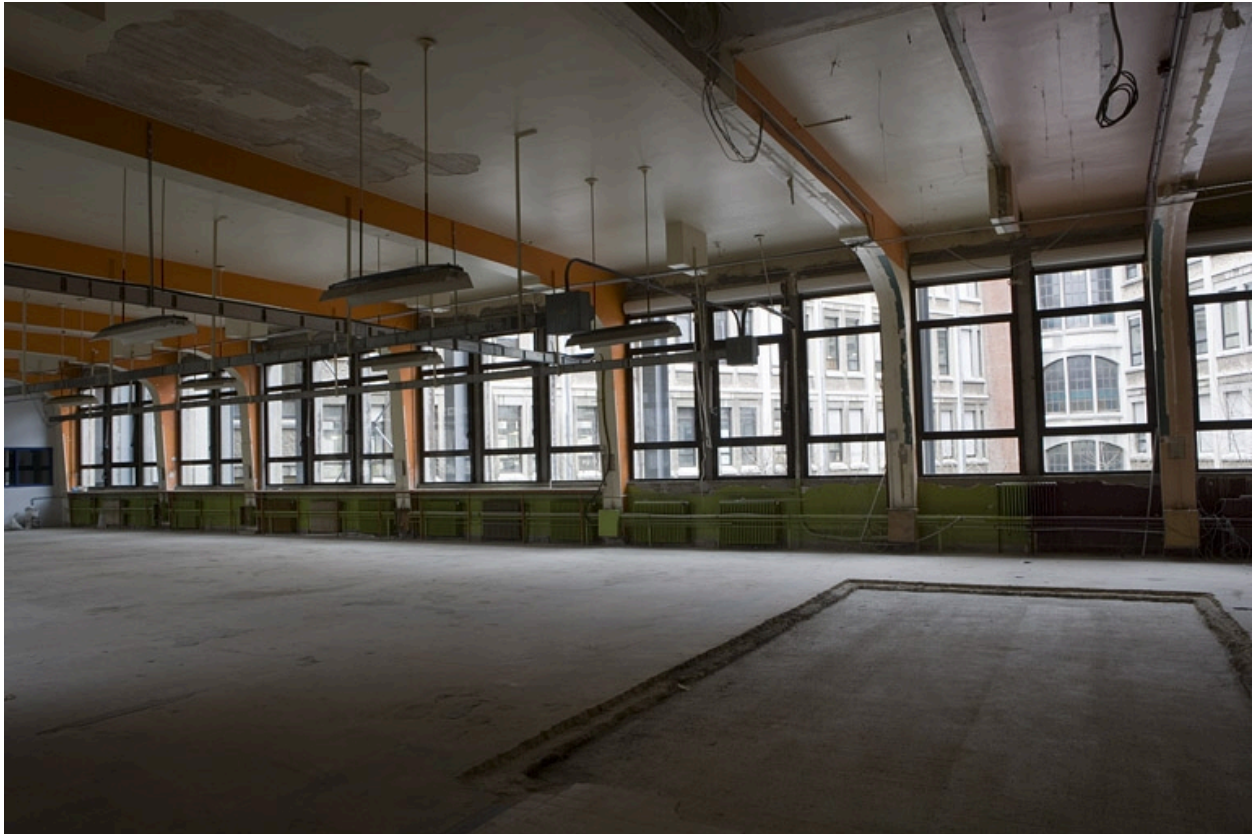
Traverse, atelier microtechnique 150 (1er étage) en 2007 avant rénovation : structure porteuse et baies.
