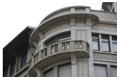
Corps d'entrée : partie supérieure de la travée de raccordement gauche. Phot. Yves Sancey IVR43_20092501508NUC2A
