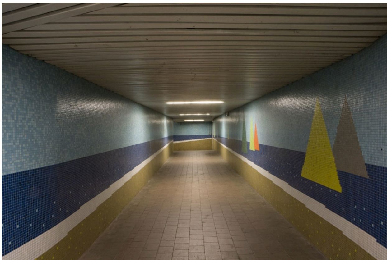
Tunnel sous l'avenue Clemenceau.
