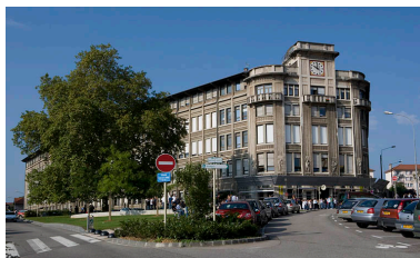
Vue d'ensemble depuis l'est, en 2006. Phot. Yves Sancey IVR43_20062501156NUCA
