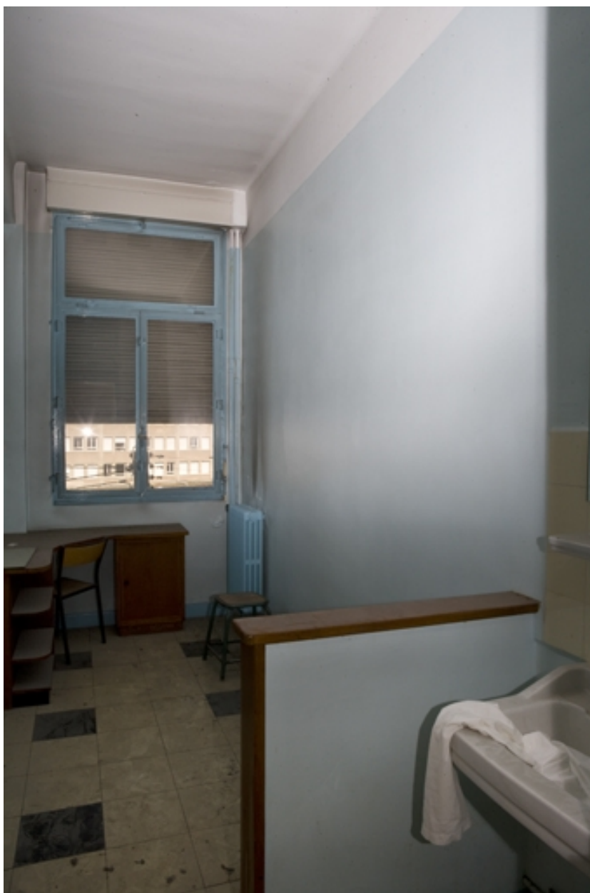
Aile nord (3e étage) : chambre d'inspecteur, depuis l'entrée.
