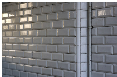
Aile nord, atelier de mécanique 190 (1er étage) : carrelage mural des sanitaires. Phot. Yves Sancey IVR43_20092501524NUC2A
