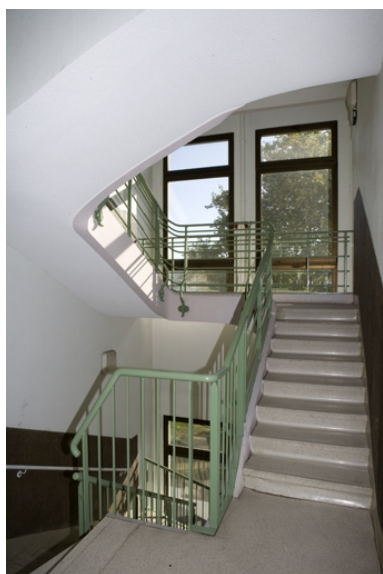
Aile sud : escalier Labonne. Phot. Yves Sancey IVR43_20092501521NUC2A
