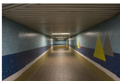
Tunnel sous l'avenue Clemenceau. Phot. Yves Sancey IVR43_20092501535NUC2A
