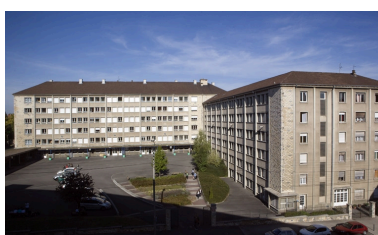
Internat : vue d'ensemble. Phot. Yves Sancey IVR43_20092501480NUC2A
