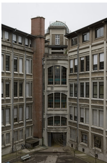
Corps d'entrée : façade sur cour. Phot. Yves Sancey IVR43_20072500041NUCA
