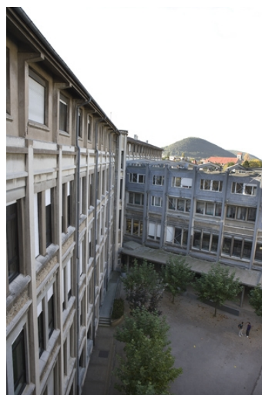
Aile sud et traverse : façade sur cour. Phot. Yves Sancey IVR43_20092501478NUC2A
