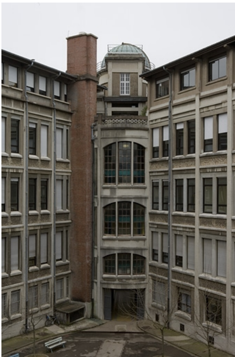
Corps d'entrée : façade sur cour.
