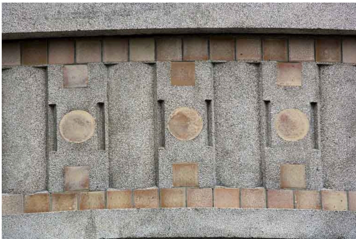
Corps d'entrée : carreaux et disques en grès flammé.
