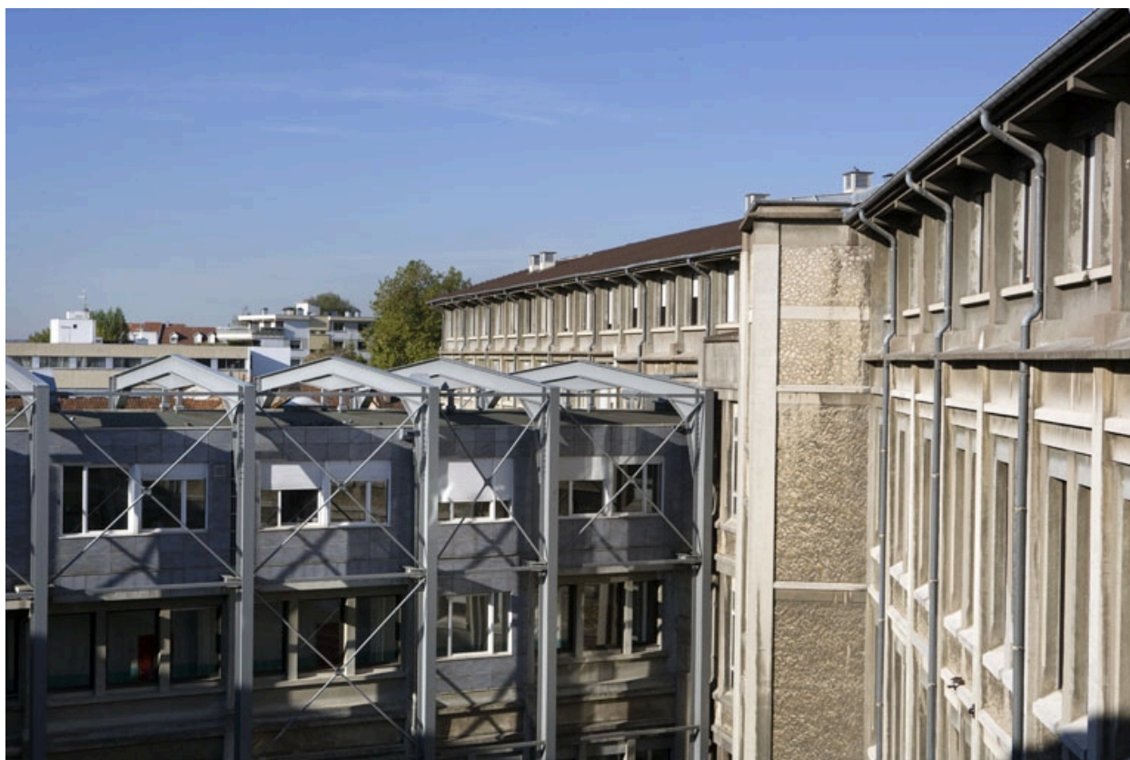
Aile nord et traverse : façade sur cour.
