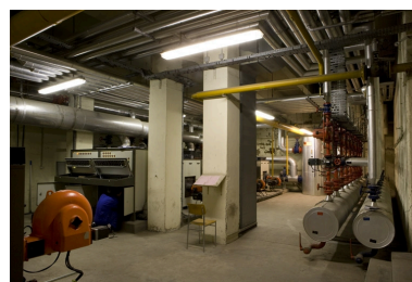
Corps d'entrée, chaufferie : vue d'ensemble. Phot. Yves Sancey IVR43_20092501519NUC2A
