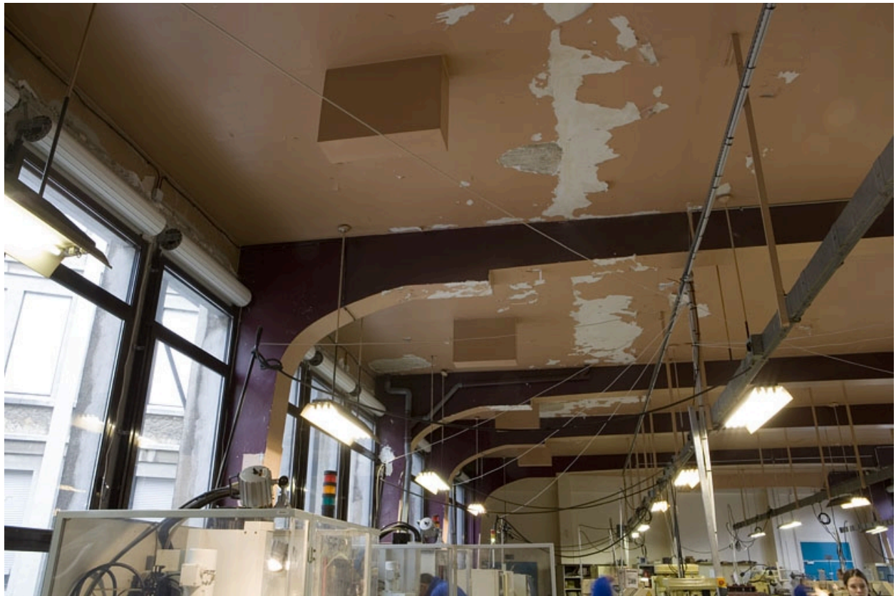
Traverse, atelier microtechnique (1er étage) : détail de la jonction poteau-poutre. Atelier microtechnique 120 en 2007, avant rénovation.
