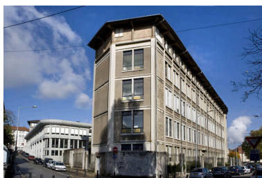
Extrémité de l'aile sud et bâtiment Coste. Phot. Yves Sancey IVR43_20092501492NUC2A
