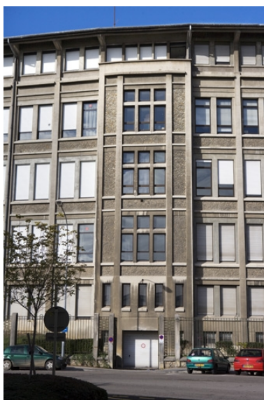
Aile sud : travée à la jonction des deux corps de bâtiment. La porte d'entrée du premier niveau donne sur le garage du directeur. Phot. Yves Sancey IVR43_20092501490NUC2A
