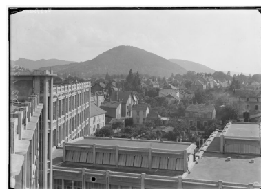
[Vue plongeante sur la façade sur la cour de l'aile sud, la terrasse et le lanterneau de la traverse C], vers 1932.
