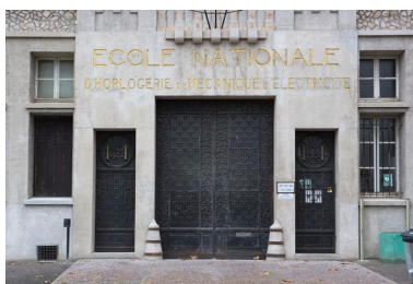
Corps d'entrée : portail et inscription. Phot. Yves Sancey IVR43_20092501548NUC2A
