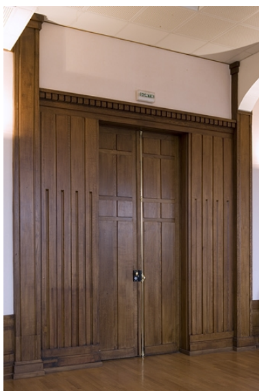
Corps d'entrée, amphithéâtre Labbé : détail d'une porte. Phot. Yves Sancey IVR43_20072500032NUCA
