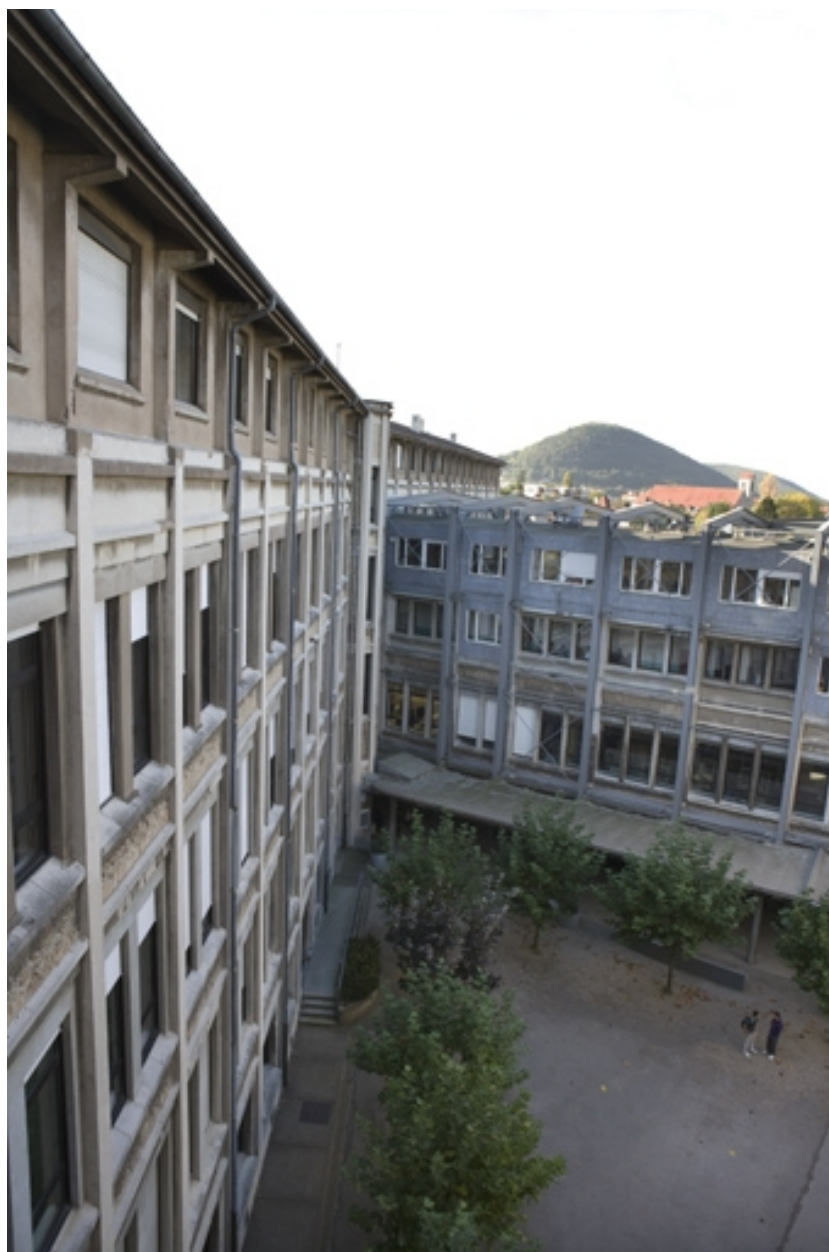
Aile sud et traverse : façade sur cour.
