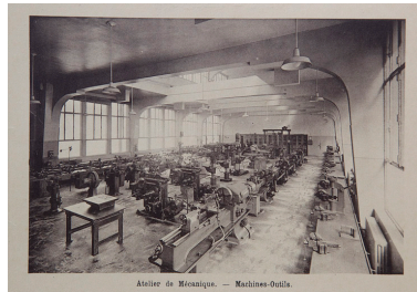
Ecole nationale de Besançon. Atelier de mécanique. - Machines-outils, 1933 ? Phot. Yves Sancey IVR43_20112502358NUC2A
