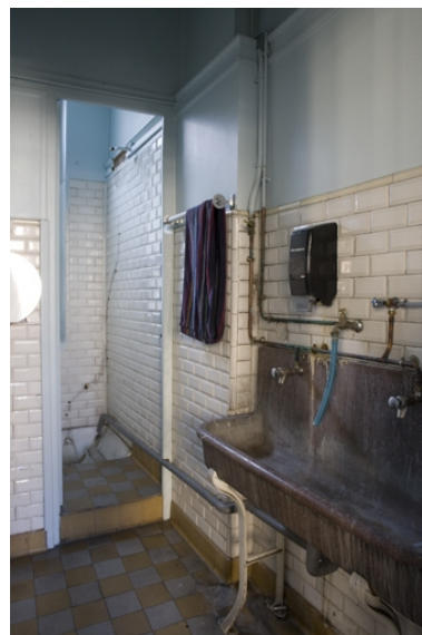
Aile nord, atelier de mécanique 190 (1er étage) : sanitaires. Phot. Yves Sancey IVR43_20092501523NUC2A
