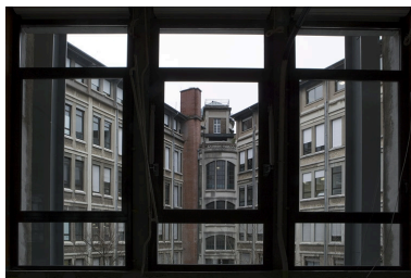
Traverse, atelier microtechnique (1er étage) : baie, avec vue sur la partie supérieure du corps d'entrée. Atelier microtechnique en 2007, avant rénovation. Phot. Yves Sancey IVR43_20072500040NUCA
