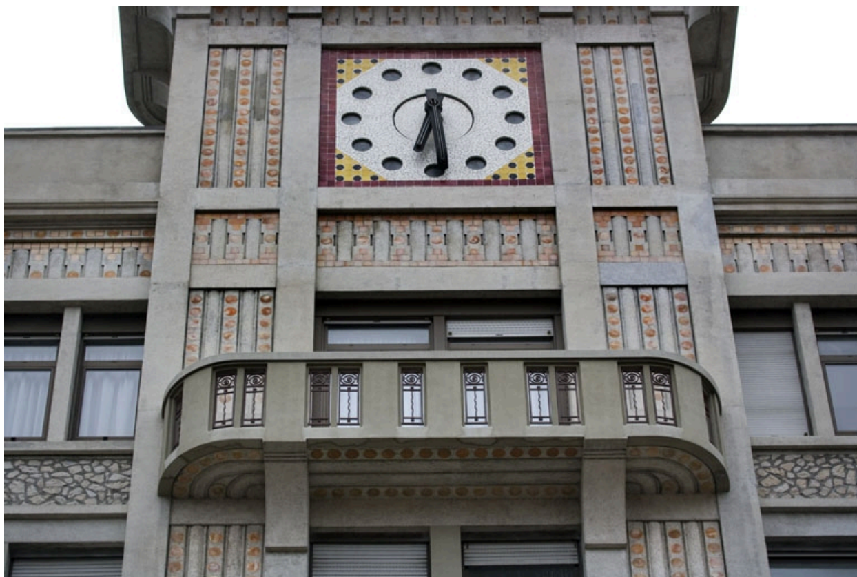
Corps d'entrée : partie supérieure de la travée centrale.
