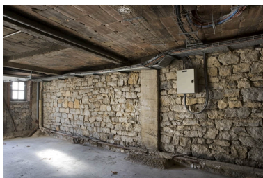
Aile sud, garage du directeur : maçonnerie de moellons et hourdis de briques. Phot. Yves Sancey IVR43_20092501518NUC2A
