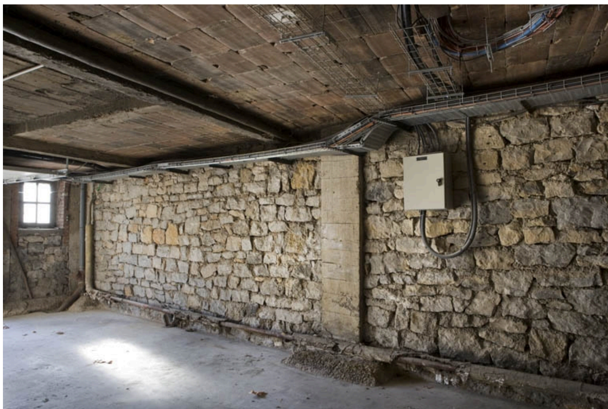
Aile sud, garage du directeur : maçonnerie de moellons et hourdis de briques.
