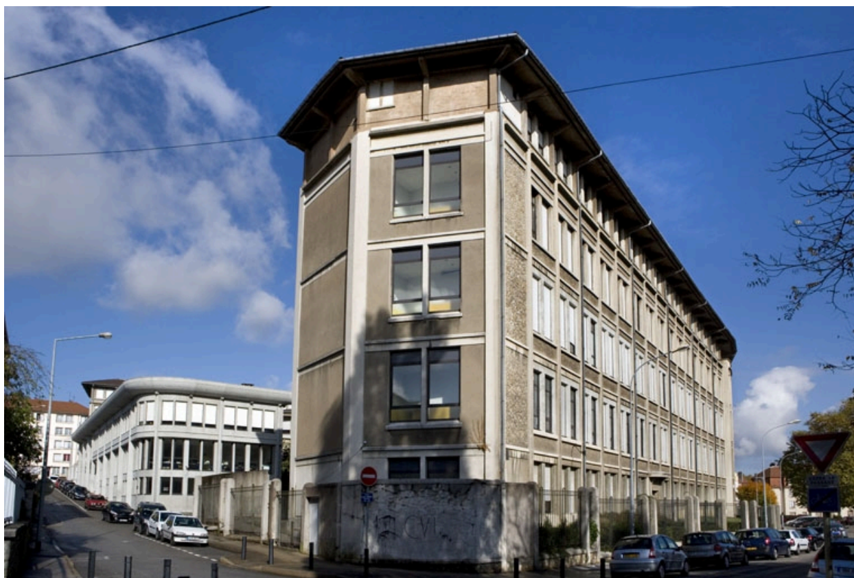
Extrémité de l'aile sud et bâtiment Coste.
