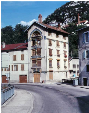
Logement sud de trois quarts droite. Phot. Jérôme Mongreville IVR43_19923900597XA
