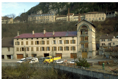
Vue d'ensemble depuis l'ouest. Phot. Laurent Poupard IVR43_19923901421ZA
