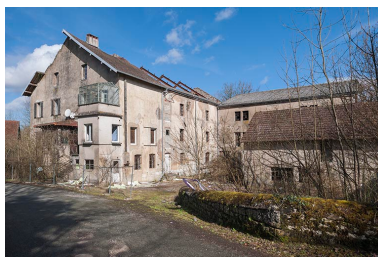
Vue d'ensemble depuis la rue du Canal. Phot. Jérôme Mongreville IVR43_20152500332NUC4A
