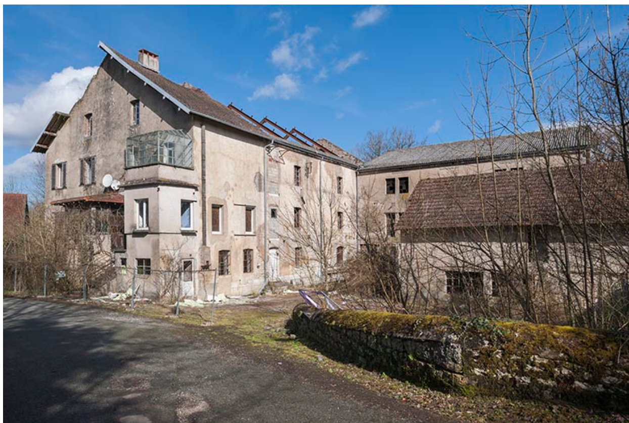
Vue d'ensemble depuis la rue du Canal.
