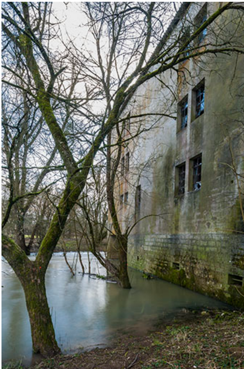
Façade nord du magasin industriel.
