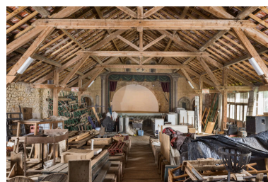
La scène, vue de la salle. Phot. Pierre-Marie Barbe-Richaud IVR26_20242100208NUC4A
