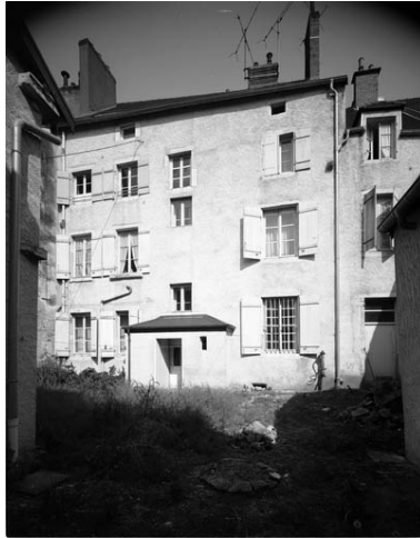
Façade postérieure. Phot. Yves Sancey IVR43_19897000253V
