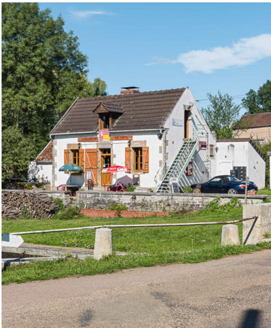
Vue de la maison éclusière.
