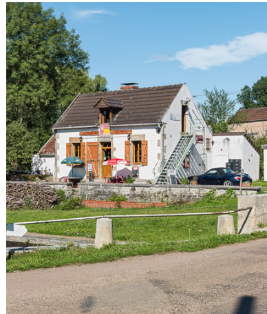
Vue de la maison éclusière. Phot. Pierre-Marie Barbe-Richaud IVR26_20175800345NUC2A
