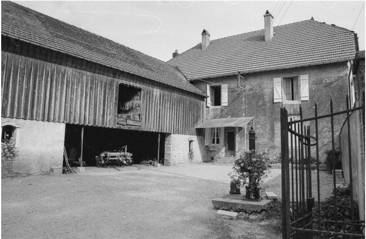
L'habitation : façade sur cour gauche.
