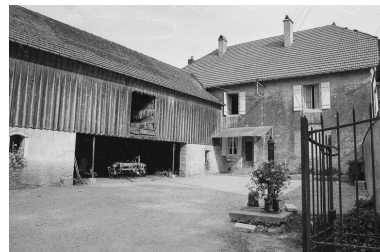
L'habitation : façade sur cour gauche. Phot. Bernard Lardière IVR43_19797000251Z
