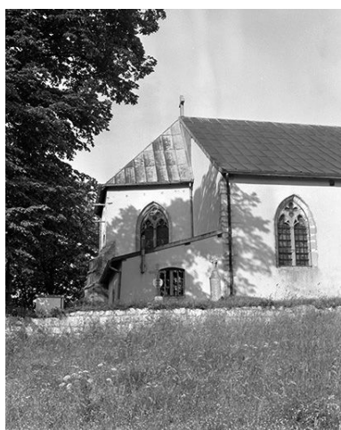
Façade latérale gauche du chœur.
