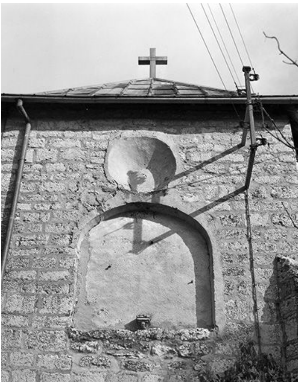
Baies murées du chevet.
