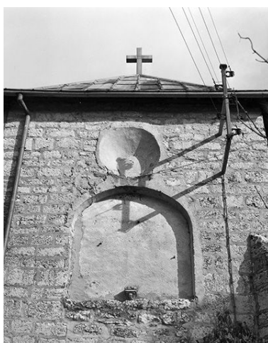
Baies murées du chevet.
