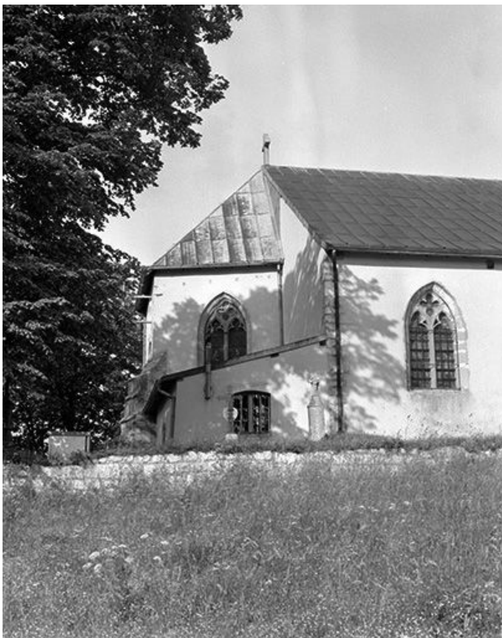
Façade latérale gauche du choeur.
