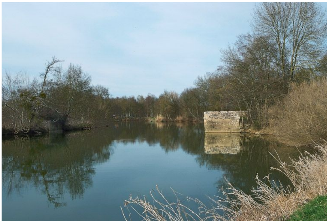
Pile de l'ancien pont à bascule.
