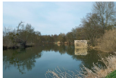
Pile de l'ancien pont à bascule. Phot. Jean-Luc Duthu IVR26_20107100487NUC2A
