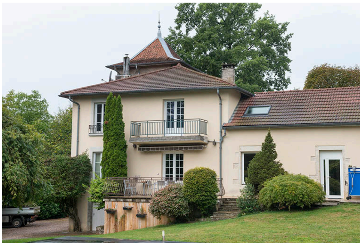
Partie sud de la façade côté parc.
