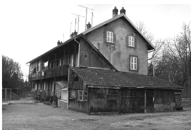
Vue d'ensemble. Phot. Bernard Lardière IVR43_19832500271Z
