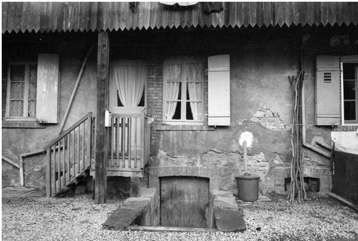
Façade postérieure : détail.
