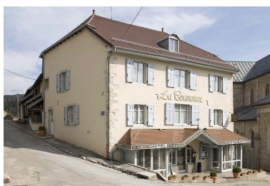
Façade antérieure et façade latérale gauche. Phot. Jérôme Mongreville IVR43_20092500463NUC2A
