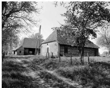
Vue générale. Phot. Bernard Lardière IVR43_19793900299X
