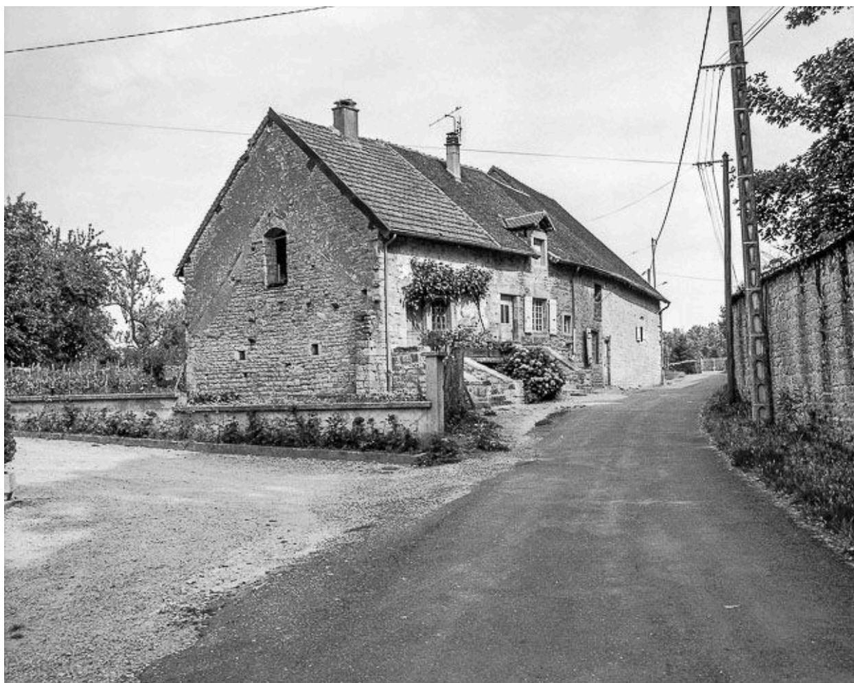
Maison de vigneron située rue de l'Hospital.
