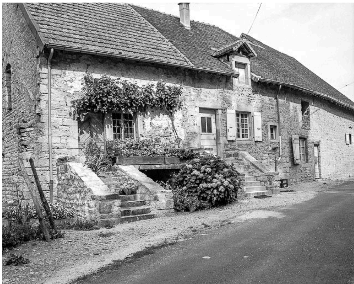
Maison de vigneron située rue de l'Hospital.
